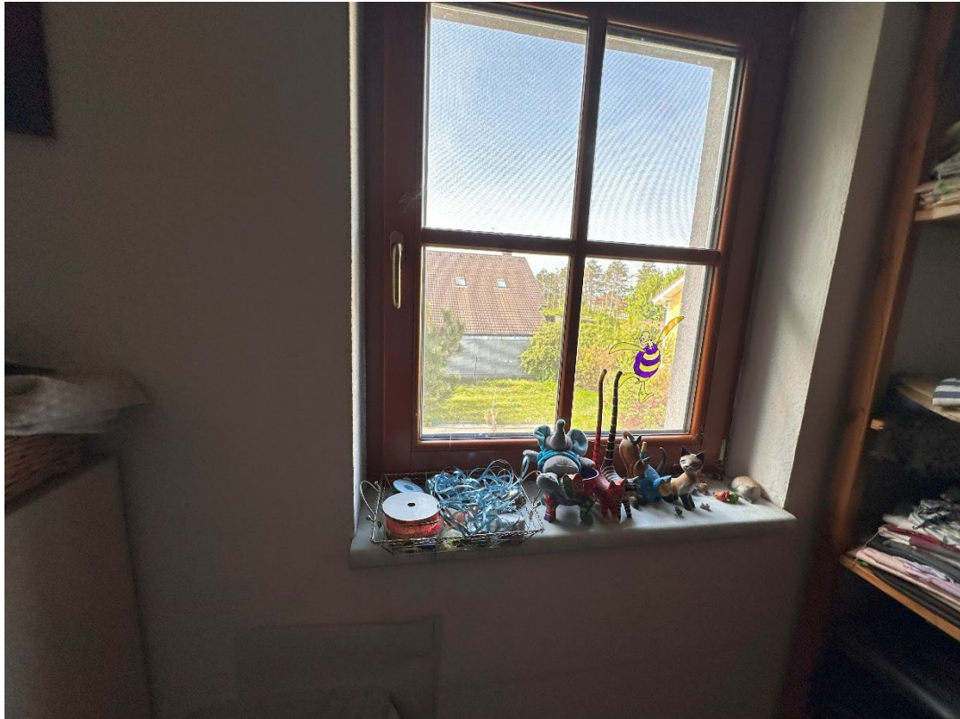
Foto 87: DG | südöstliches Zimmer - Fenster
