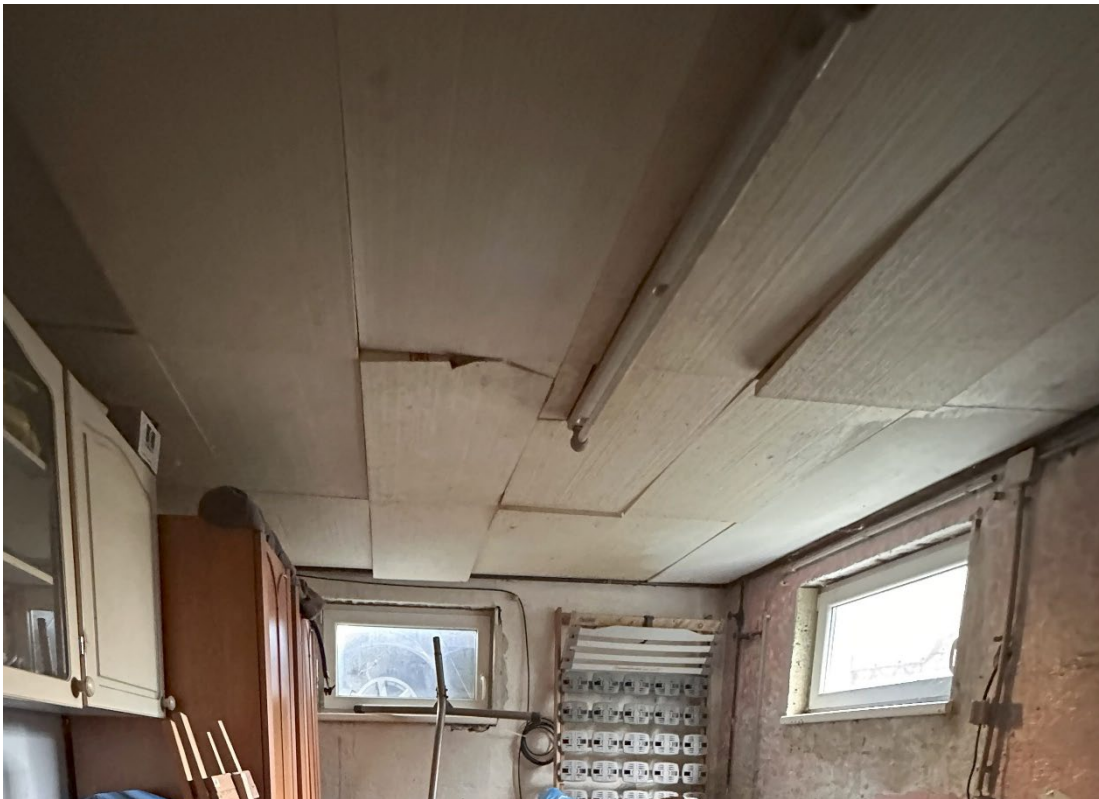
Foto 1: Wärmedämmung der Kellerdecke zum Erdgeschoß
