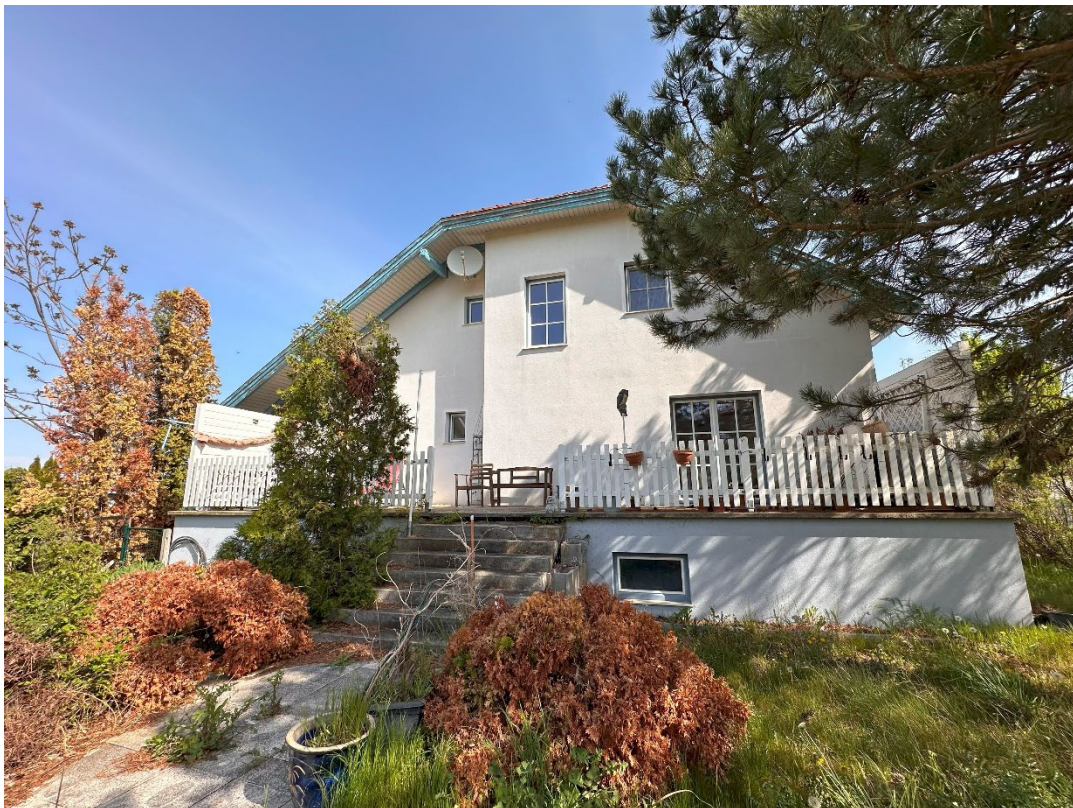
Foto 6: Süd Ansicht Einfamilienhaus
