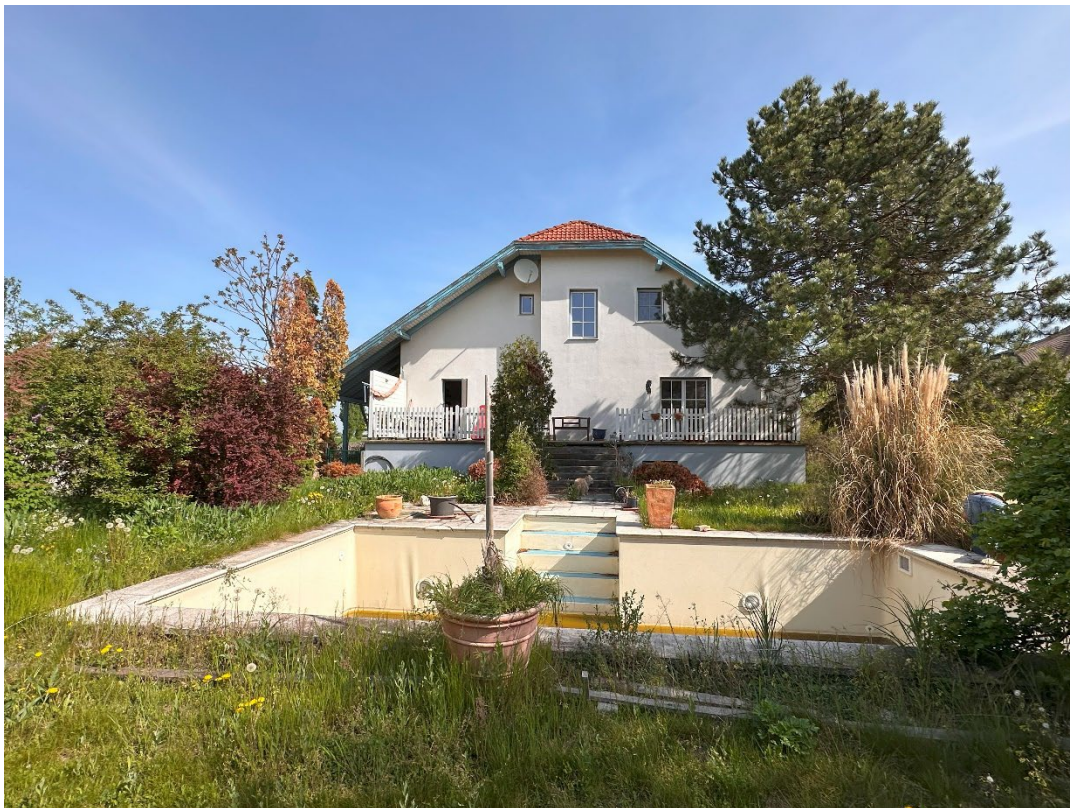
Foto 14: südlicher Gartenbereich mit Pool und Zugang zur Terrasse
