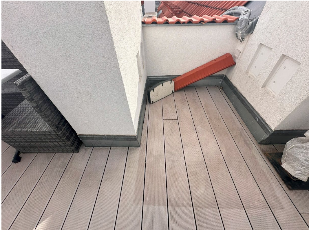
Foto 33: Top D 3 | Dachterrasse
