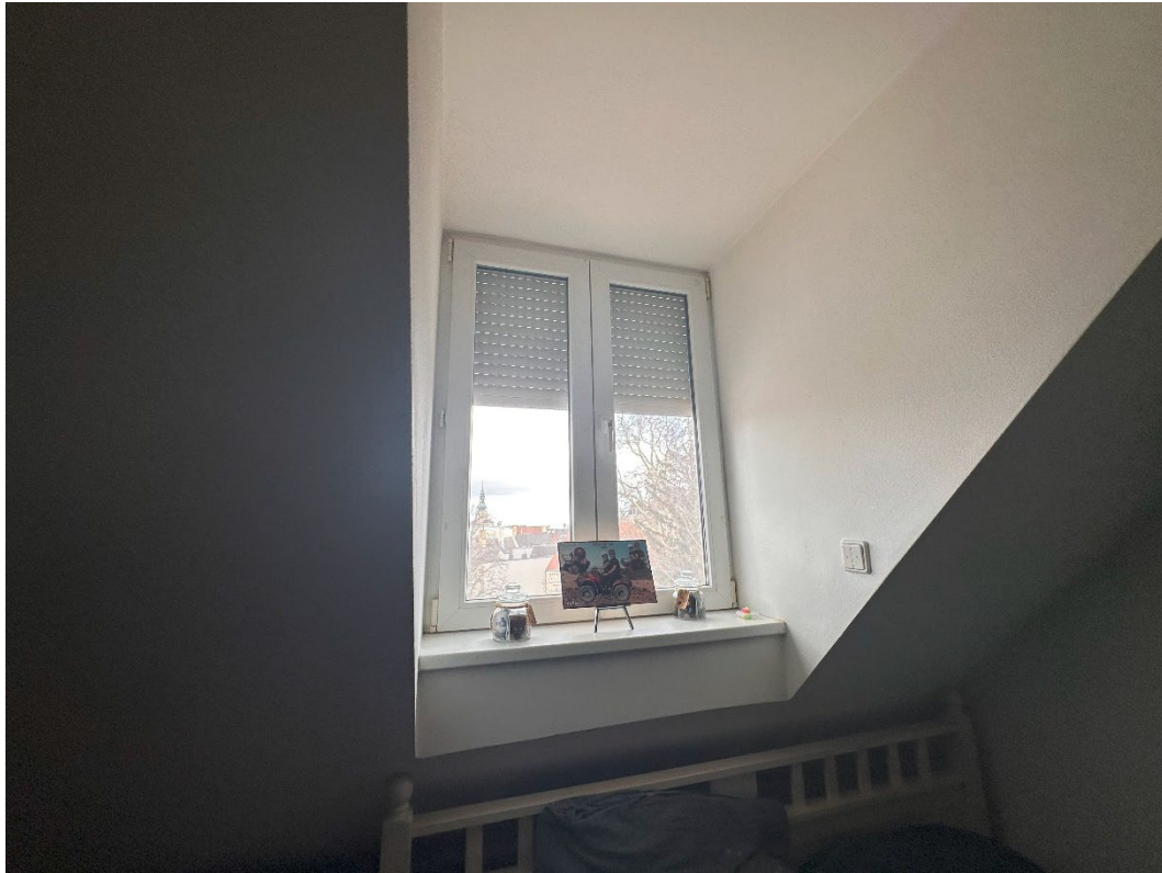
Foto 51: Top D 4 | Zimmer - Fenster
