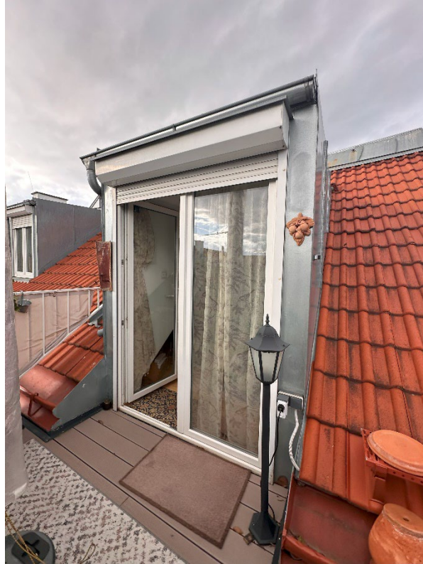
Foto 19: Top D 3 | Zugang Balkon
