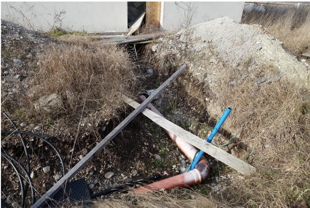
Foto 6 – Künette (Kanal, Wasser) vor Haus 3
