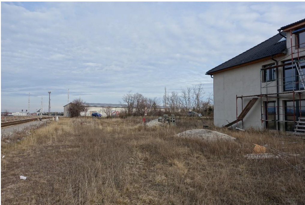
Foto 14 – Grüngürtel-Lärmschutz (Blickrichtung Nord-Osten)
