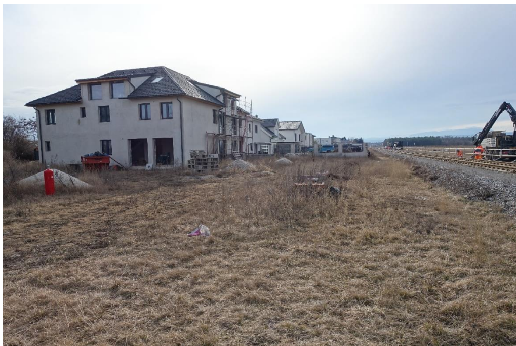
Foto 10 – Grüngürtel-Lärmschutz (Blickrichtung Süd-Westen)
