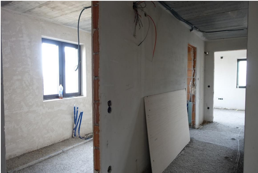
Foto 23 – Haus 3 (Gang + Bad/WC)
