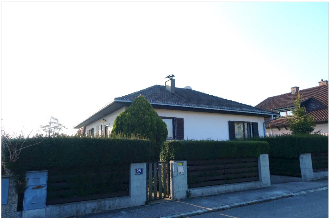
Foto 2 – Straßenansicht und Einfriedung
