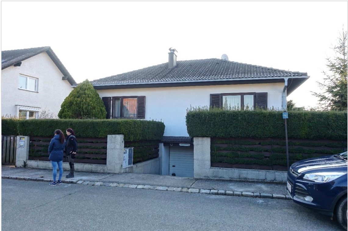
Foto 1 – Straßenansicht (Nordwestseite) mit Abfahrt in Garage
