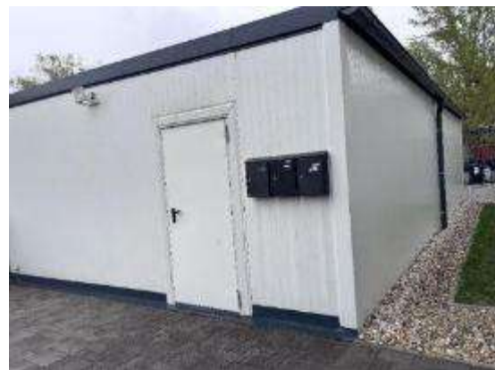
Garage – nachträglich errichtet
