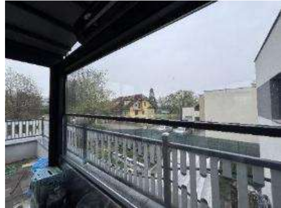
Dachterrasse mit Geländer
