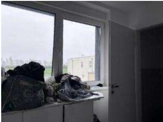
Fenster im Vorzimmer
