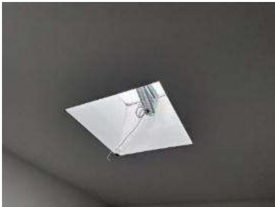
Dachluke im Stiegenhaus
