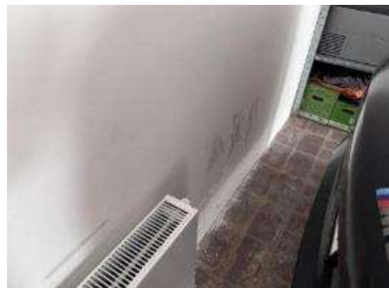
Feuchtigkeitsspuren - Garage
