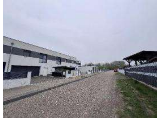
Blick von der Straße
