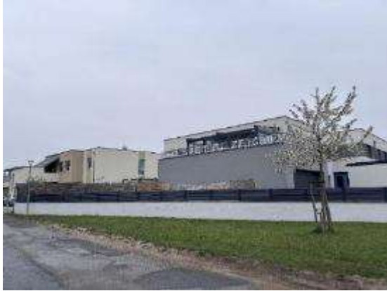
Blick zur Dachterrasse
