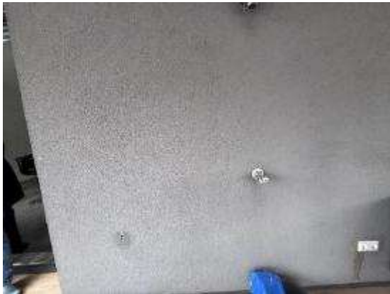
Wasser-/ Stromanschluss Terrasse
