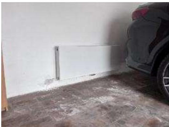
Feuchtigkeitsspuren - Garage
