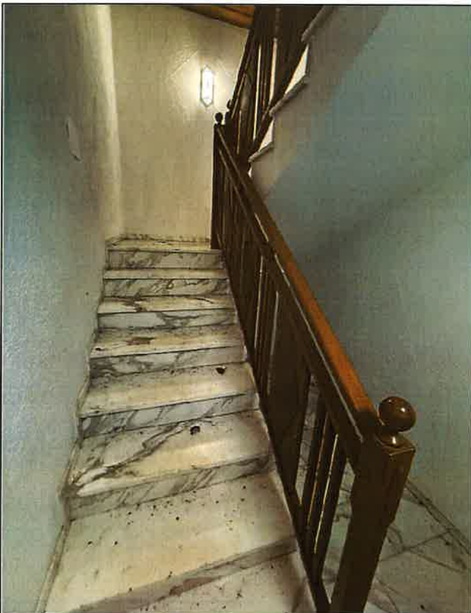
über das Stiegenhaus ins Erdgeschoss
