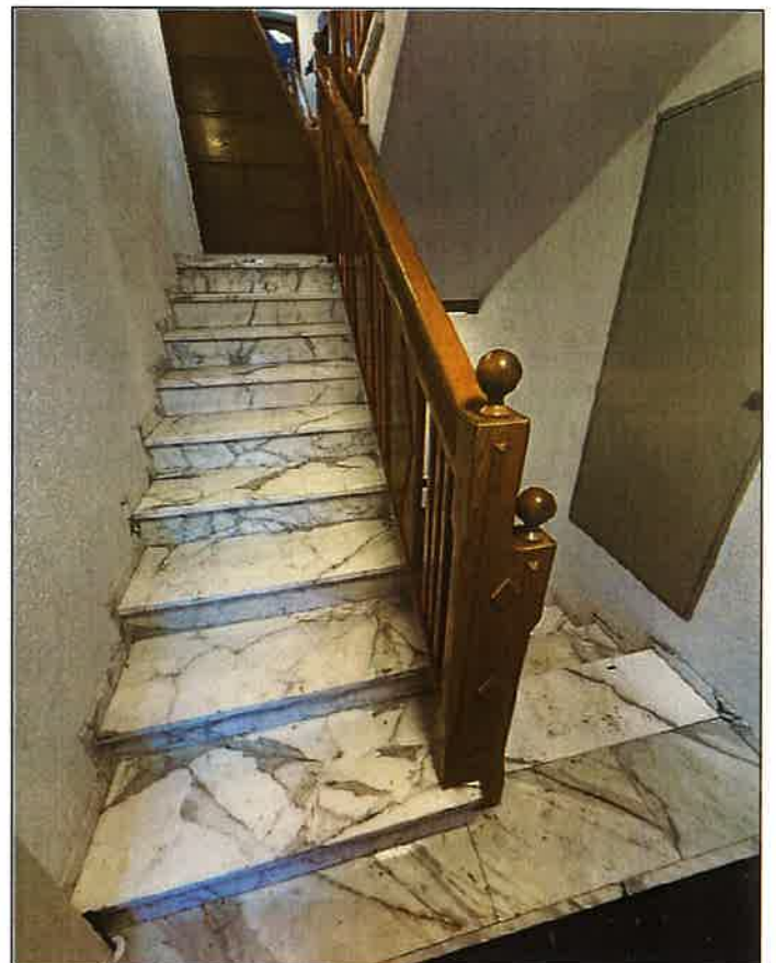
Über das Stiegenhaus mit Naturstein-Setz- und -Tritstufen ins Obergeschoss
