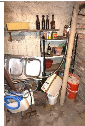
Vorraum: Boden: Beton; Wände: teilweise verputzt, teilweise Vollziegelmauerwerk unverputzt; Decke: Gewölbedecke verputzt;
