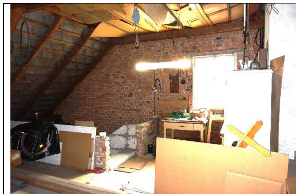
Dachboden: Boden: Aufbeton;
