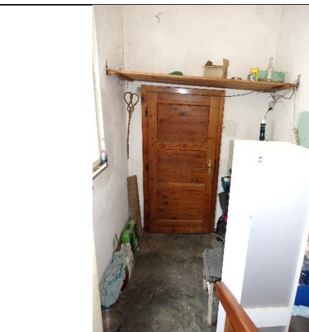
Waschküche: Boden: Beton; Wände und Decke: verputzt und gemalt;
