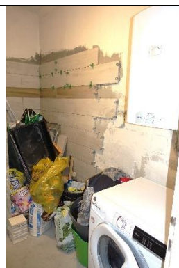
Sanitärausstattung: 1 Stand-WC mit Spülkasten, 1 Elektrowarmwasserspeicher (Fassungsvermögen ca. 50 l), 1 Waschmaschinenanschluss;
