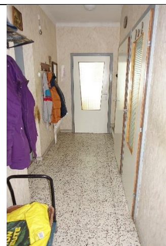
Vorraum: Boden: Terrazzoplatten; Wände und Decke: verputzt und gemalt;
