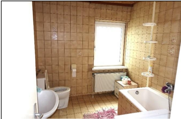
Bad/WC: Boden: Fliesen; Wände: Fliesen; Decke: Profilholzdecke; Sanitärausstattung: 1 Waschbecken mit Armatur, 1 Stand-WC mit Spülkasten, 1 Badewanne mit Armatur; 1 Waschmaschinenanschluss;
