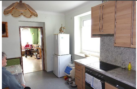
Küche: Boden: Kunststoffbelag; Wände und Decke: verputzt und gemalt;
