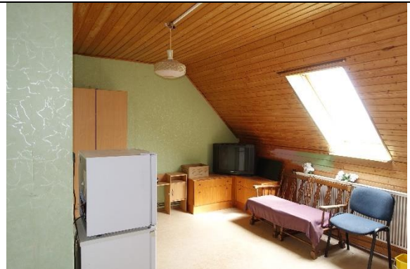
Zimmer 5: Boden: Kunststoffbelag; Wände: Tapeten; Dachschräge und Decke: Profilholzverkleidung;
