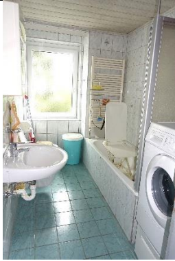
Bad/WC: Boden: Fliesen; Wände: Fliesen; Decke: Paneeldecke; Sanitärausstattung: 1 Waschbecken, 1 Badewanne mit Armaturen, 1 Hänge- WC mit Unterflurspülkasten, 1 Waschmaschinenanschluss; 1 Handtuchheizkörper;
