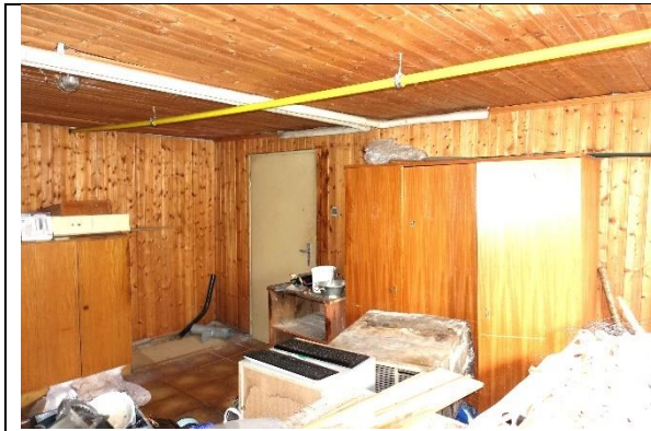
Keller 4: Boden: Fliesen; Wände und Decke: Profilholzverkleidung;
