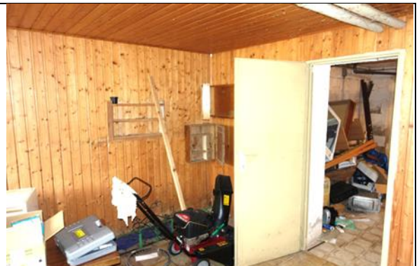
Keller 3: Boden: Fliesen; Wände und Decke: Profilholzverkleidung;
