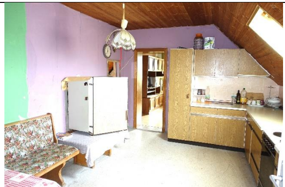
Küche: Boden: Kunststoffbelag; Wände: Tapeten; Dachschräge und Decke: Profilholzverkleidung;
