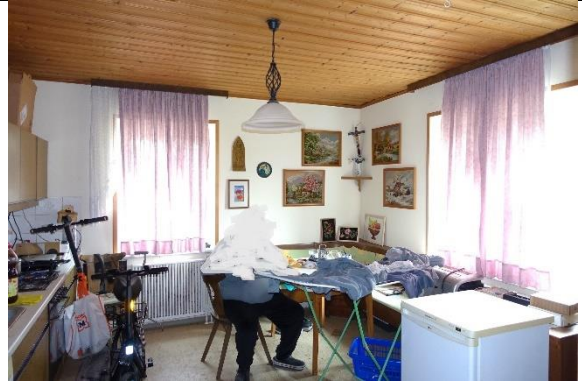
Zimmer 1/Küche: Boden: Kunststoffbelag; Wände: verputzt und gemalt; Decke: Profilholzdecke; ZUBEHÖR: 1 einzeiliger Einbauküchenblock mit Unter- und Oberschränken; Fronten und Arbeitsplatten: beschichtet; Einbauten: 1 Nirosta-Spüle mit Armatur, 1 Gas-herd vierflammig; 1 Elektrobackrohr; geschätztes Alter zumindest ca. 30 Jahre und somit ohne Verkehrswert;
