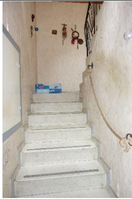
Treppe Parterre/Mansarde: eine zweiläufige Massivtreppe mit Podest jeweils mit Terrazzobelag; Absturzsicherung: Metallgeländer;
