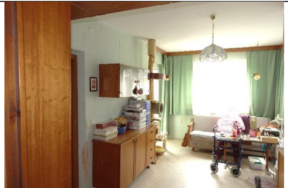
Zimmer 4: Boden: Kunststoffbelag; Wände: Tapeten; Decke: verputzt und gemalt;
