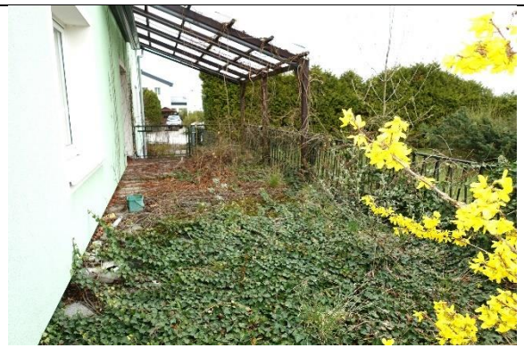
Terrasse: Boden: Betonplatten; Metallgeländer lackiert; teilweise Überdachung: Holzständerkonstruktion mit Pultdach; Eindeckung: Kunststoff-Wellplatten;
