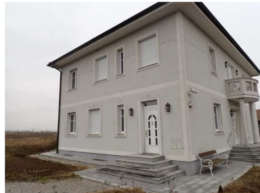
Ost- und Südfassade
