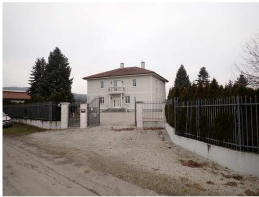
Einfriedung und Einfahrtstor
