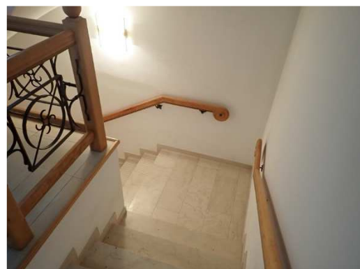
Stiegenanlage in das Kellergeschoß
