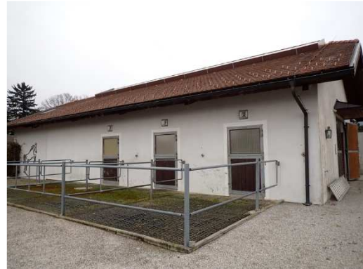
Nordfassade mit vorgelagerten Paddocks
