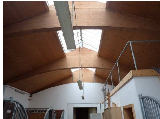
Untersicht der Holzbauweise mit lichtdurchlässigen Tafeln
