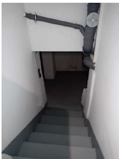
Stiegenanlage in das erste Obergeschoß
