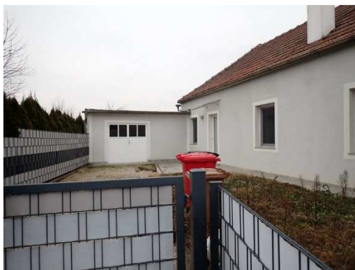
Südfassade Wohnhaus und Ostfassade Garage
