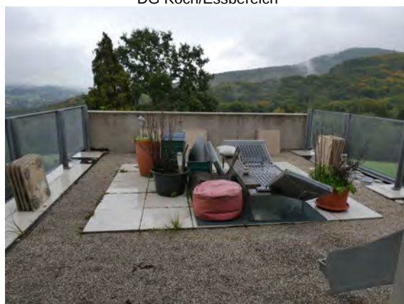
DG Terrasse Nord/Ost/Südseite
