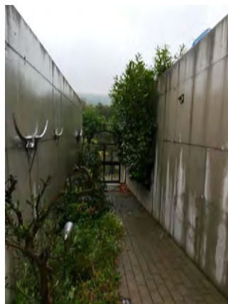
Zugang zum Gebäude in Richtung Süden
