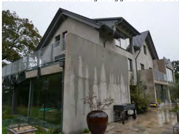
West- und Südseite
