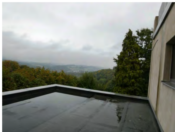
... und Terrasse in Richtung Nordosten (noch ohne Absturzsicherung)
