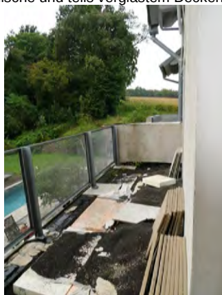
... und südseitigem Balkon
