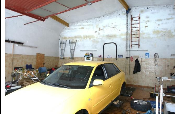
Garage: Boden: Fliesen; Wände: teilweise Fliesen, teilweise verputzt und gemalt; Decke: verputzt und gemalt; 1 Decken-Laufkatze mit Seilzug;
