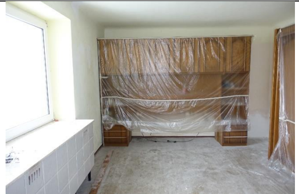
Zimmer: Boden: Estrich; Wände und Decke: verputzt und gemalt;
