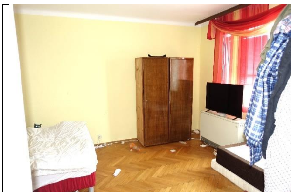
Kammer: Boden: Fischgrät-Parkettboden; Wände und Decke: verputzt und gemalt;
