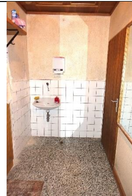
Vorraum 2: Boden: Terrazzoboden; Wände: teilweise Fliesen, teilweise verputzt und gemalt; Decke: Paneeldecke; Sanitärausstattung: 1 Handwaschbecken;
