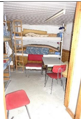
Schutzraum: Boden: Beton versiegelt; Wände: teilweise verputzt und gemalt, teilweise Profilholzverkleidung; Decke: Paneeldecke;
