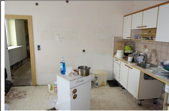
Kammer/Küche: Boden: Kunststoffbelag; Wände und Decke: verputzt und gemalt;
