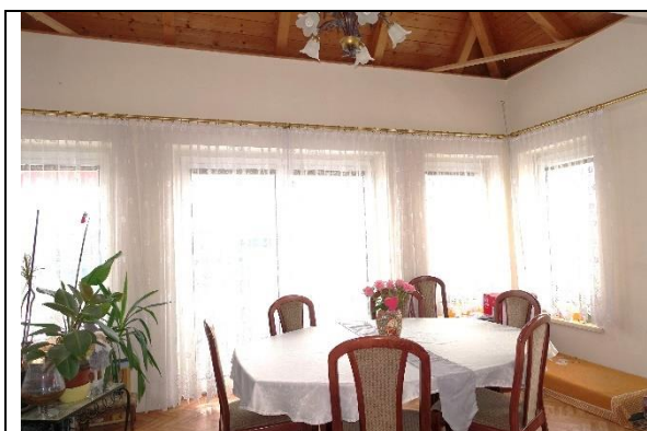
Zimmer/Zubau: Boden: Kunststoffbelag; Wände: verputzt und gemalt; Decke: Dachuntersicht-Holzbalken und Vollschalung;
