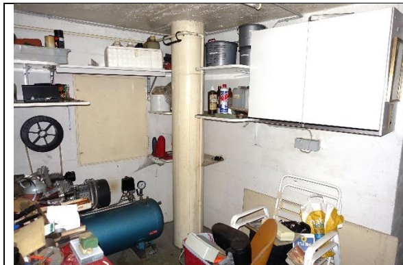
Vorraum: Boden: Beton versiegelt; Wände: verputzt und gemalt; Decke: Stahlbetondecke geweißt; Sanitärausstattung: 1 Nirostaspüle mit Armatur, 1 Elektrowarmwasserspeicher;
