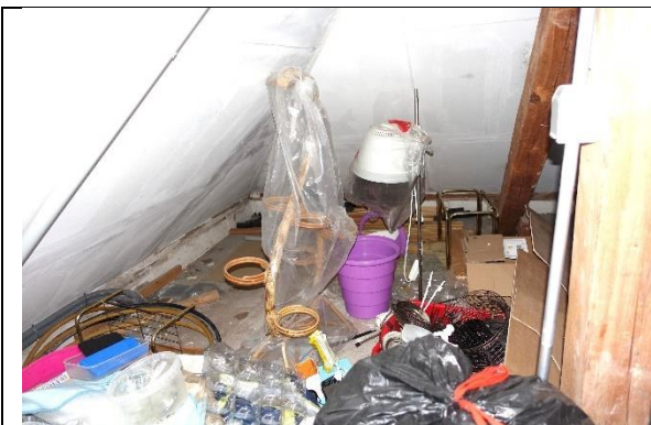
Dachboden: Boden: Beton; Dachuntersicht: Fermacell Platten grob gespachtelt;
