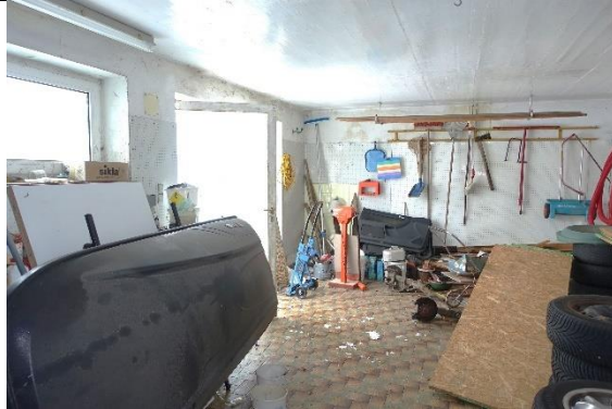
Geräteraum: Boden: Fliesen; Wände: verputzt und gemalt; Decke: Stahlbetondecke versiegelt; erkennbare Feuchtigkeitsschäden an den Wänden und der Decke;
