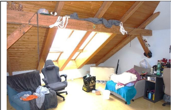
Aufenthaltsraum: Boden: Laminatboden; Wände und Dachschrägen: teilweise gespachtelt und gemalt, teilweise Holzbalken mit Holz-Vollschalung;
