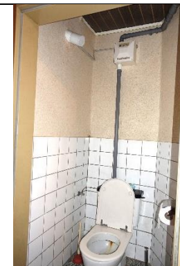
WC: Boden: Terrazzoboden; Wände: teilweise Fliesen, teilweise verputzt und gemalt; Decke: Profilholzdecke; Sanitärausstattung: 1 Stand- WC mit Spülkasten;
