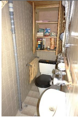
WC: Boden: Fliesen; Wände: Fliesen; Decke: Stahlbeton geweißt; Sanitärausstattung: 1 Handwaschbecken, 1 Stand-WC mit Spülkasten;
