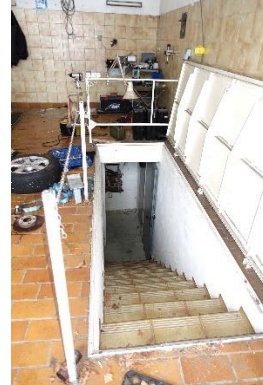
Treppe EG/KG: einläufige Massivtreppe mit Fliesenbelag und Stalblechabdeckklappe;
