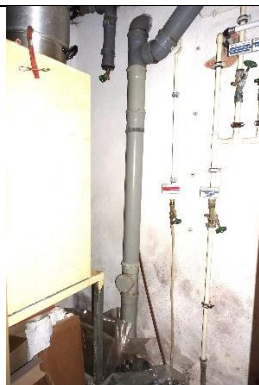
Vorraum 1: Boden: Terrazzoboden; Wände und Decke: verputzt und gemalt;
