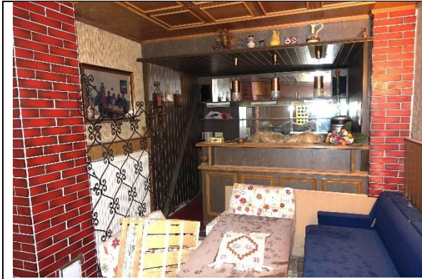
Bar: Boden: Terrazzoboden; Wände: teilweise Tapeten, teilweise Paneelverkleidung; Decke: Kassettendecke furniert;
