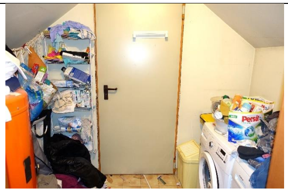
Wirtschaftsraum: Boden: Fliesen; Wände, Dachschräge: gespachtelt; 1 Elektro- Warmwasserspeicher (Fassungsvermögen 200 l), 1 Waschmaschinenanschluss; Sanitärausstattung: 1 Waschmaschinenanschluss;
