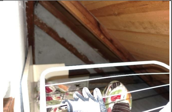
Dachboden: Boden: Dachbodendämmplatten; Wände und Decke: verputzt und gemalt;
