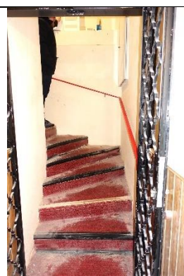
Treppe 1.KG/EG: gefächerte Massivtreppe mit Kunststoffbelag; Handlauf;
