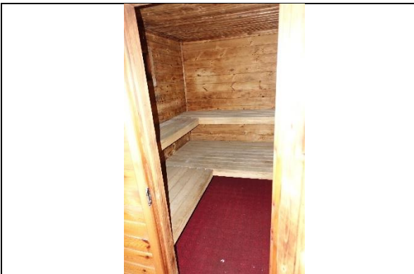
Sauna: Boden: Fliesen; Wände und Decke: Profilholzverkleidung;
