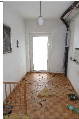
Vorraum 3: Boden: Fliesen; Wände und Decke: verputzt und gemalt;
