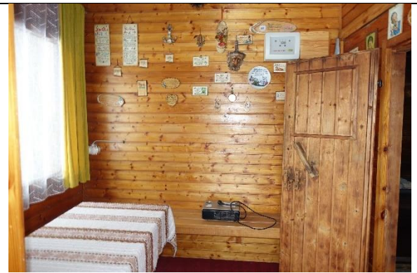
Aufenthaltsraum: Boden: Teppichboden; Wände und Decke: Profilholzverkleidung;
