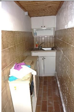
Kochnische: Boden: Fliesen; Wände: teilweise Fliesen, teilweise verputzt und gemalt; Decke: Profilholzdecke;
