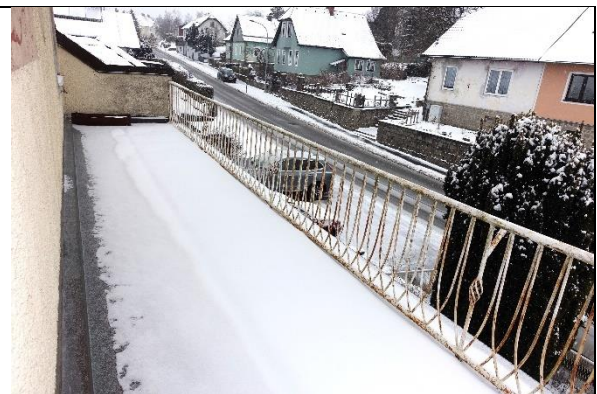
Balkon: Boden: Blechabdeckung; Metallgeländer lackiert;
