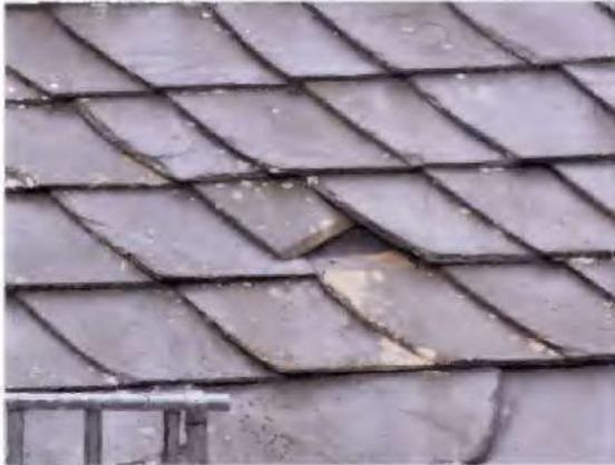
Foto 13: Detail "Dacheindeckung des Wohnhauses" (schadhaft)
