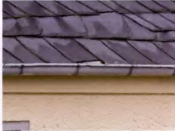
Foto 14: Detail "Dacheindeckung des Wohnhauses" (schadhaft)
