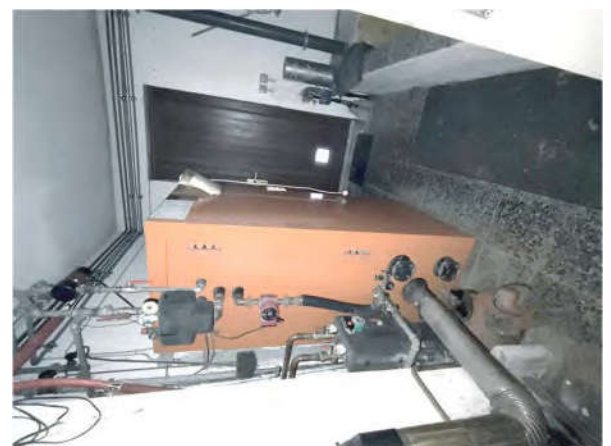
Bild 17-24 o Oben: Erdgeschoss mit Flur, E-Verteilung und Garage o Unten: Heizungsanlage (Ölheizkessel) und Tanklager; rechts unten: Wasseruhr
