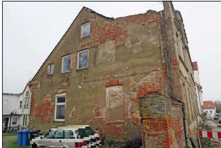
Blick auf den südlichen Giebel des Wohnhauses
