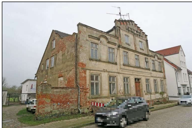
Ansicht des Mehrfamilienhauses aus südöstlicher Richtung
