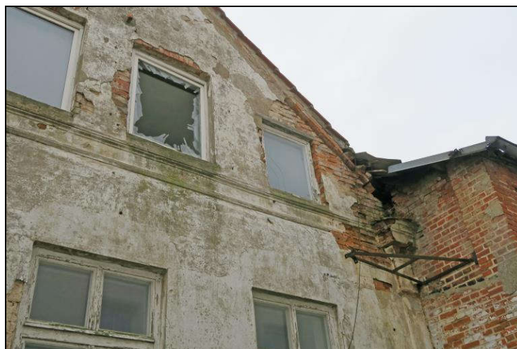
Blick auf die Nordfassade und den Übergang zum Gebäude des Nachbargrundstückes
