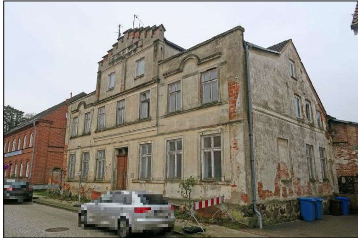
Ansicht des Mehrfamilienhauses aus nordöstlicher Richtung
