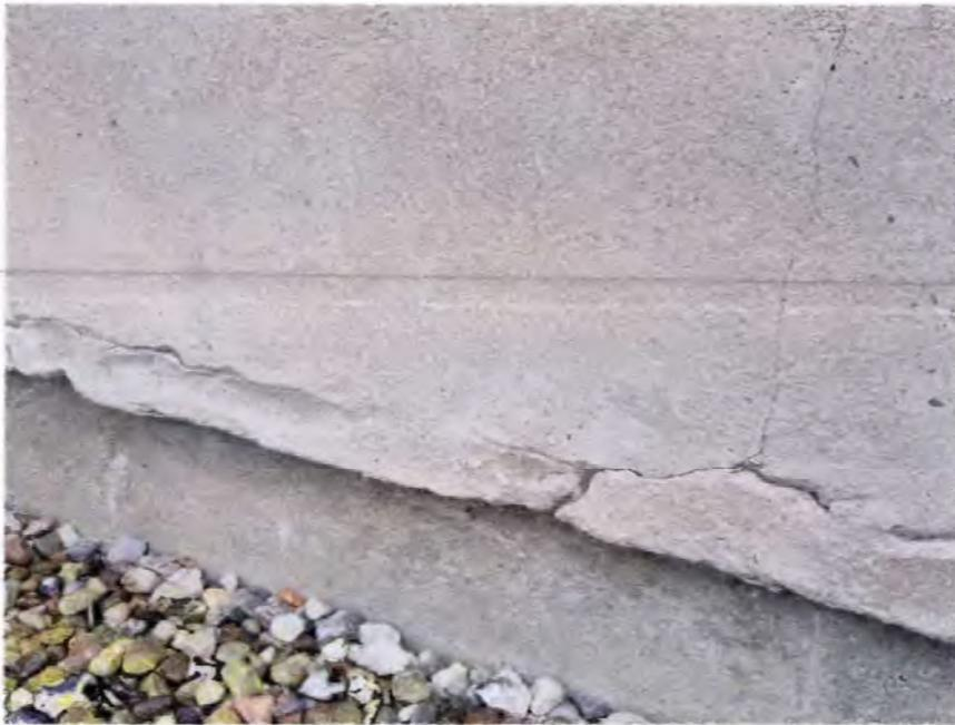
Bild 21 - Putzschäden im unteren Sockelbereich Ostfassade
