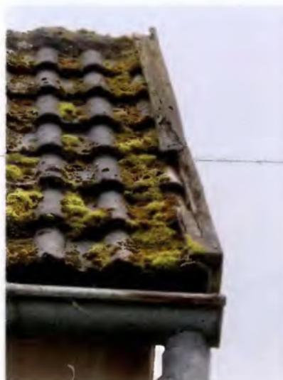
Bild 14 - Detail Dacheindeckung Bereich Ortgang mit Schäden
