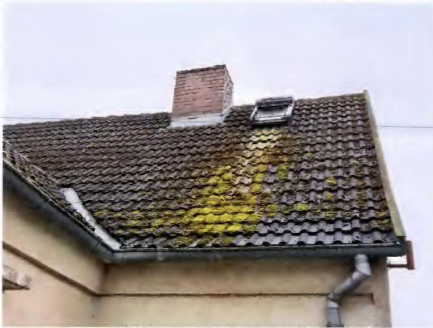
Bild 15 - vermooste Dachsteine auf der Nordseite
