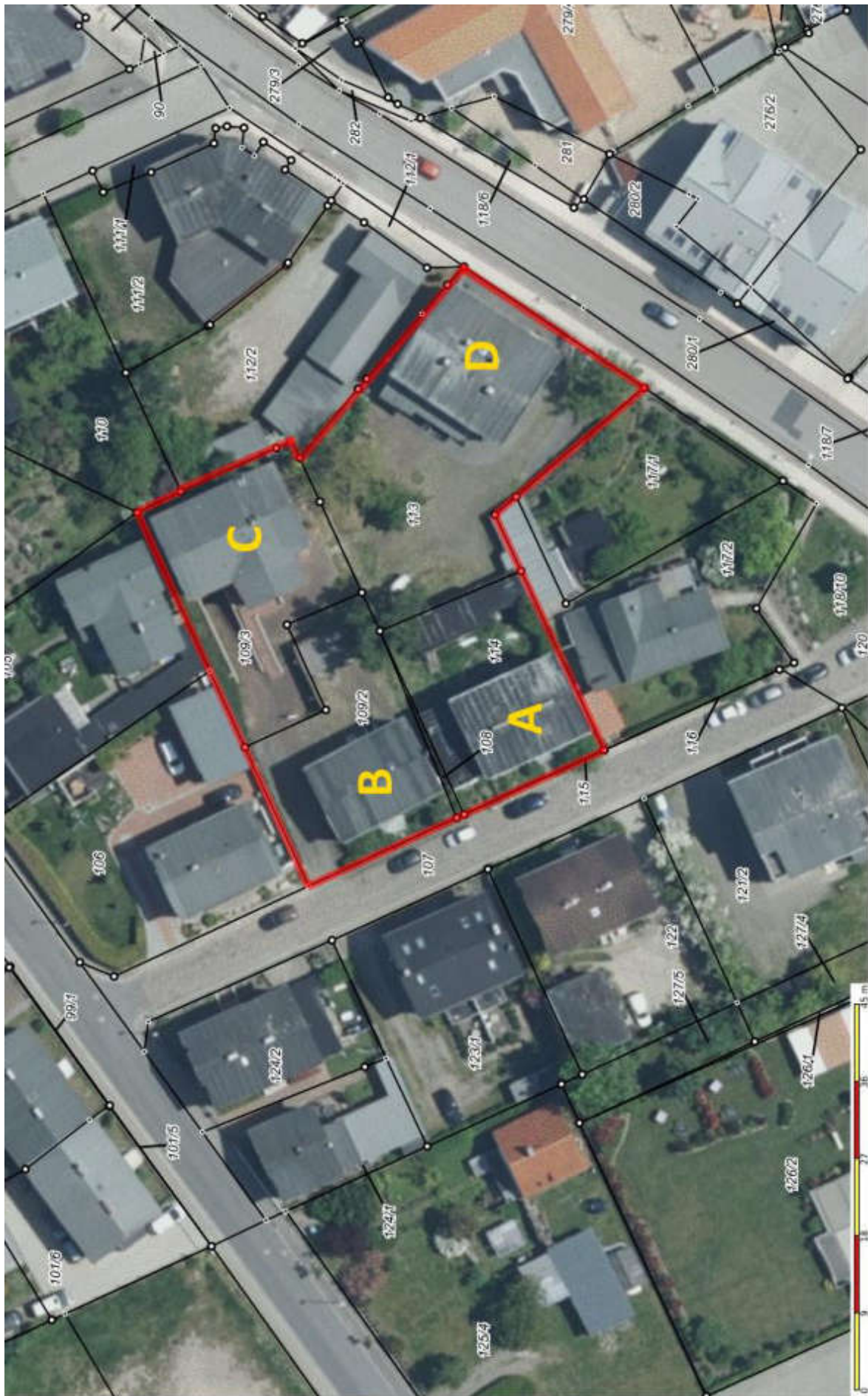
Luftbild mit Bezeichnung der baulichen Anlagen A) Radvanstraße 1; B) Radvanstraße 2; C) Radvanstraße 2a; D) Hauptstraße 62
