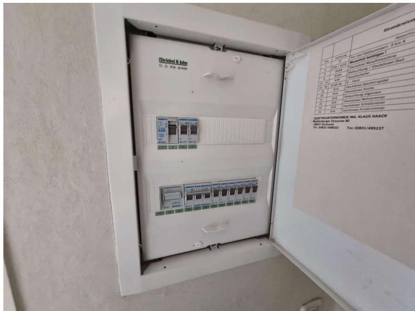
Bild 16 - Elektronterverteiler im Wohnungsflur
