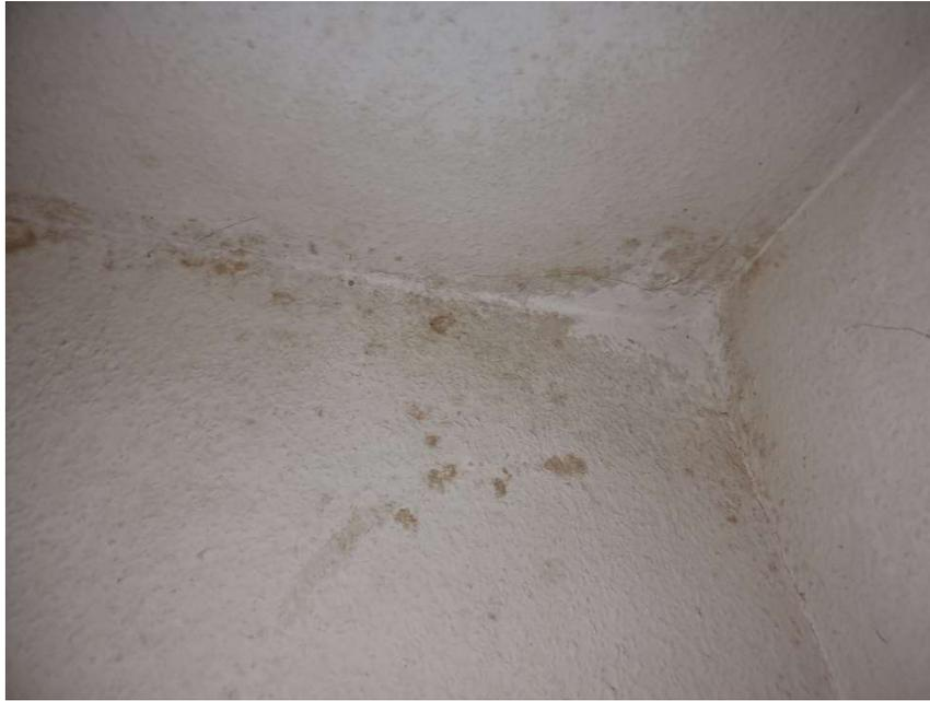
Bild 21 - Küche Wand und Deckenbereich - Renovierungsbedarf
