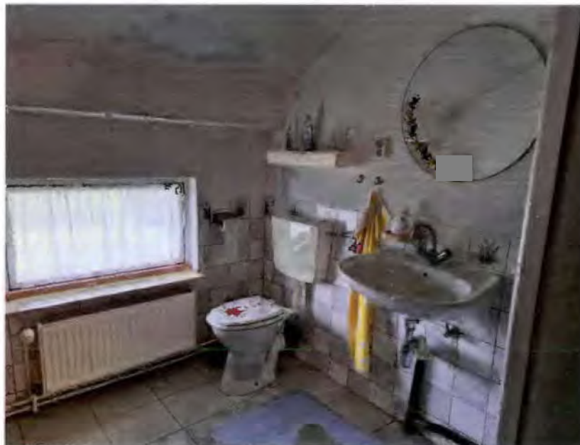
Bild 38 - Raum 22 - WC, Waschbecken
