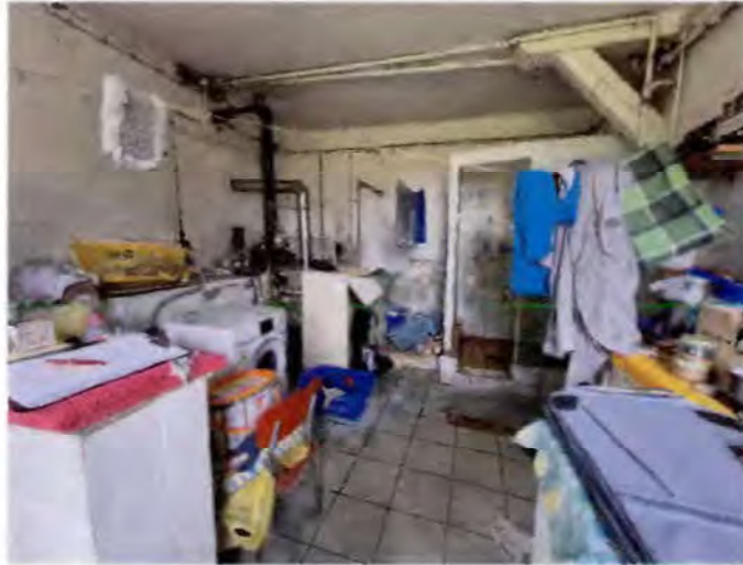
Bild 13 - Raum 4 Waschmaschinenanschluss, Heizung, Dusche
