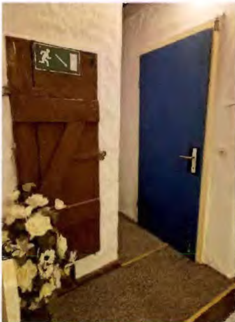
Bild 28 - Flur im Dachgeschoss
