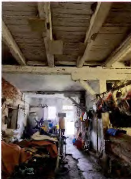
Bild 20 - Raum 12 - WC links und E-Unterverteilung
