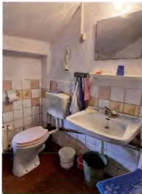
Bild 36 - Raum 21 - WC, Waschbecken
