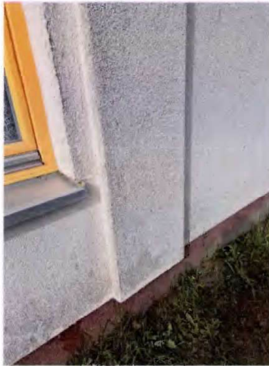
Foto 7: Detailansicht der Fassade der Doppelhaushälfte (Algenbildung)
