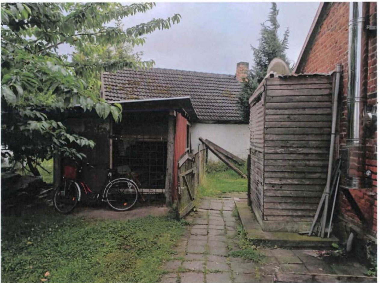
W-25-035 Bild 50 - Zugang mit Schuppen
