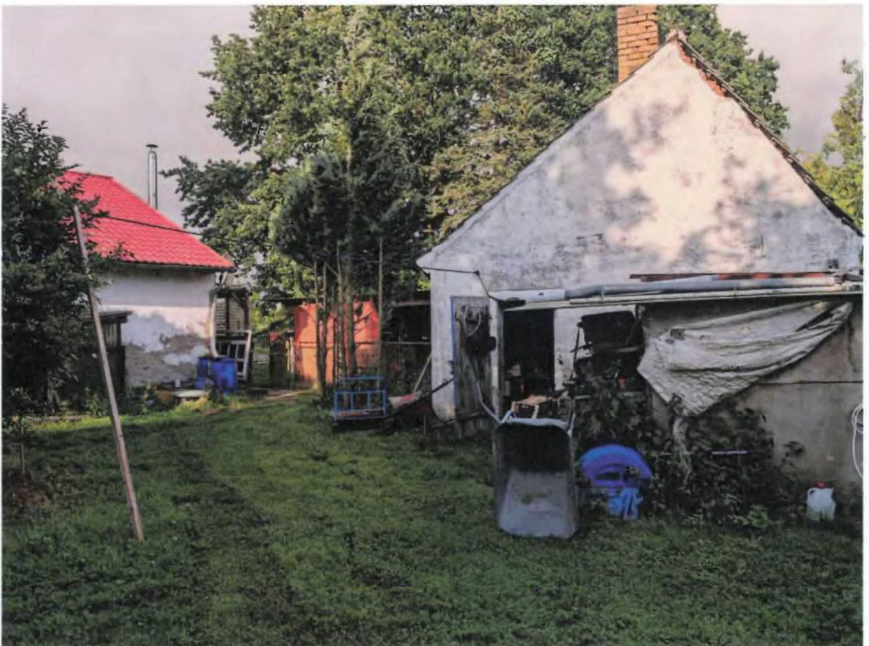
W-25-035 Bild 64 - Hofbereich
