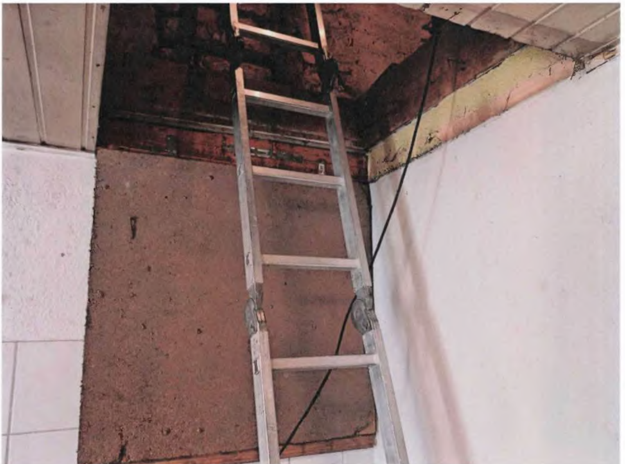
W-25-035 Bild 44 - Leiter zum Dach
