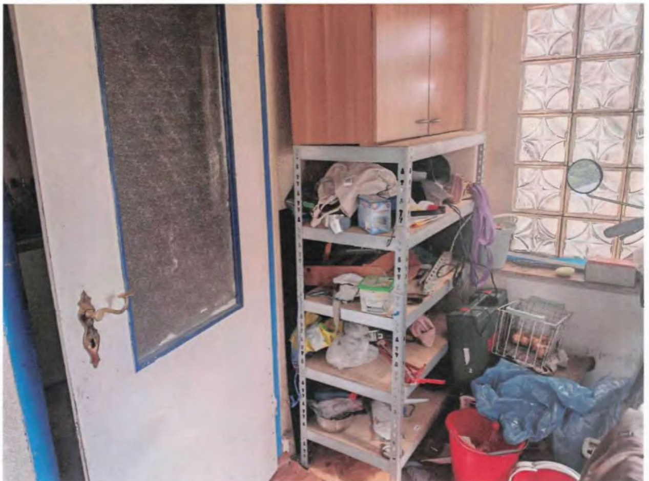
W-25-035 Bild 14 - Anbau Flur 1
