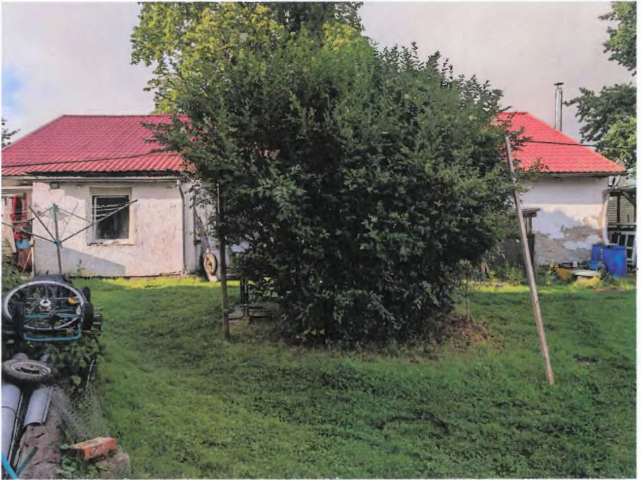
W-25-035 Bild 63 - Hofbereich
