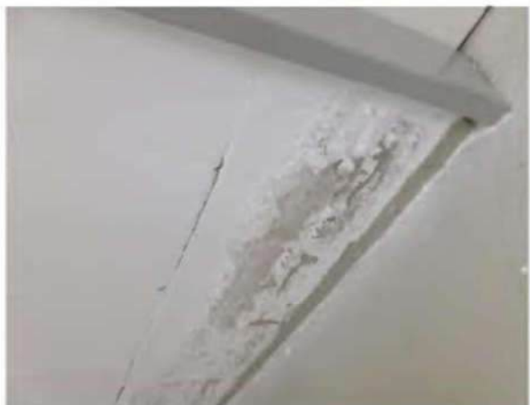
Bild 12-19 o Oben: Kelleransicht; rechts Keller Nr.11 o Unten: Ansicht von Bauschäden im Keller (aufsteigende Nässe)
