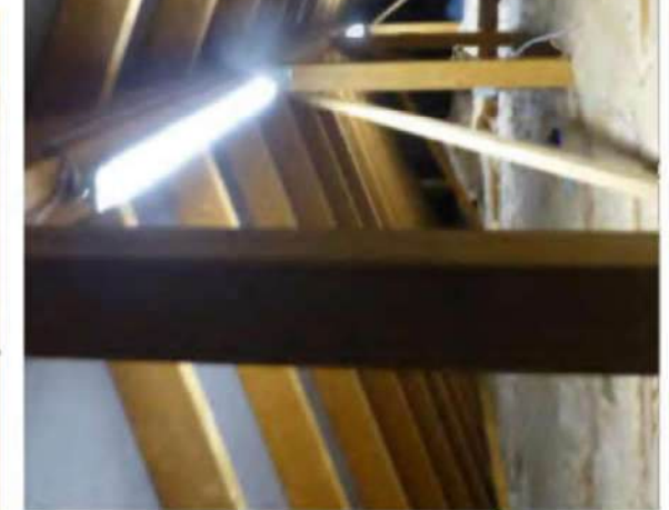
Bild 20-26 o Oben: Treppenhausansichten o Unten: Ansichten vom Spitzboden
