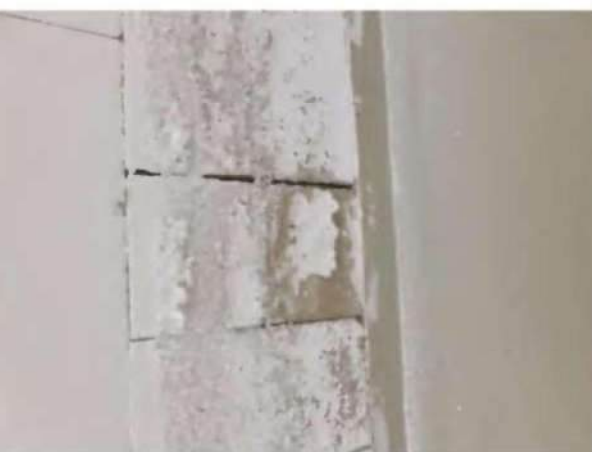
Bild 12-19 o Oben: Kelleransicht; rechts Keller Nr.11 o Unten: Ansicht von Bauschäden im Keller (aufsteigende Nässe)
