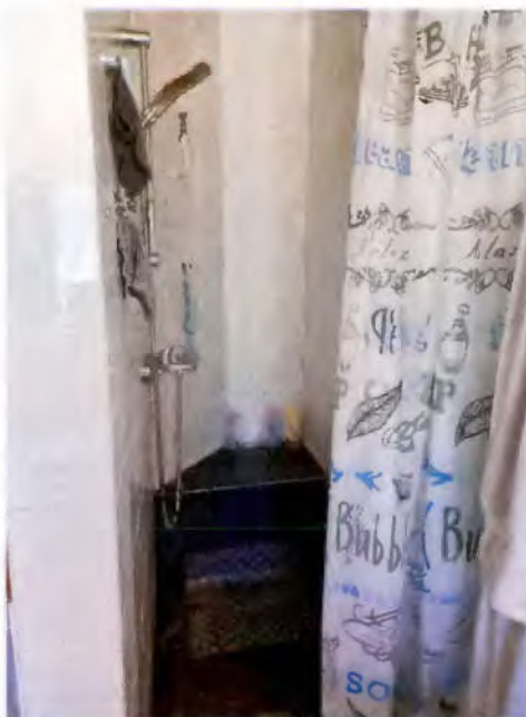
Bild 28 - Duschbereich im Bad des Erdgeschosses
