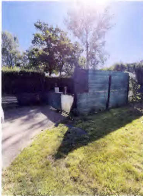
Bild 17 - Blick vom Vorgarten auf die Grundstückseinfahrt
