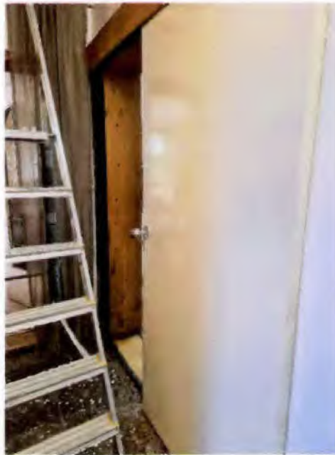
Bild 29 - Detail Küchentür (Schiebetür)
