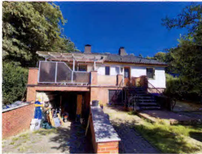
Bild 1- Vorder-/Südansicht des Wohnhauses
