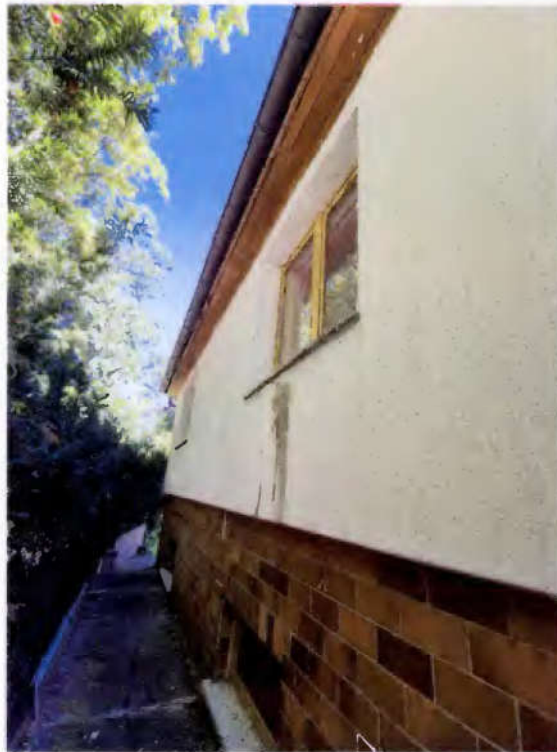
Bild 11 - Teilansicht Fassade an der Westseite
