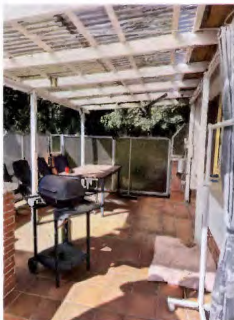
Bild 10 - überdeckte Terrasse an der Vorderseite des Wohnhauses
