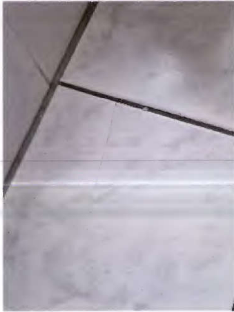
Boden Detail Fliesen 1
