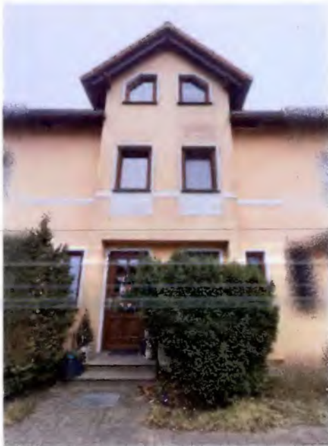
Eingangs-/Vorderansicht (Blick etwa aus Richtung Osten)
