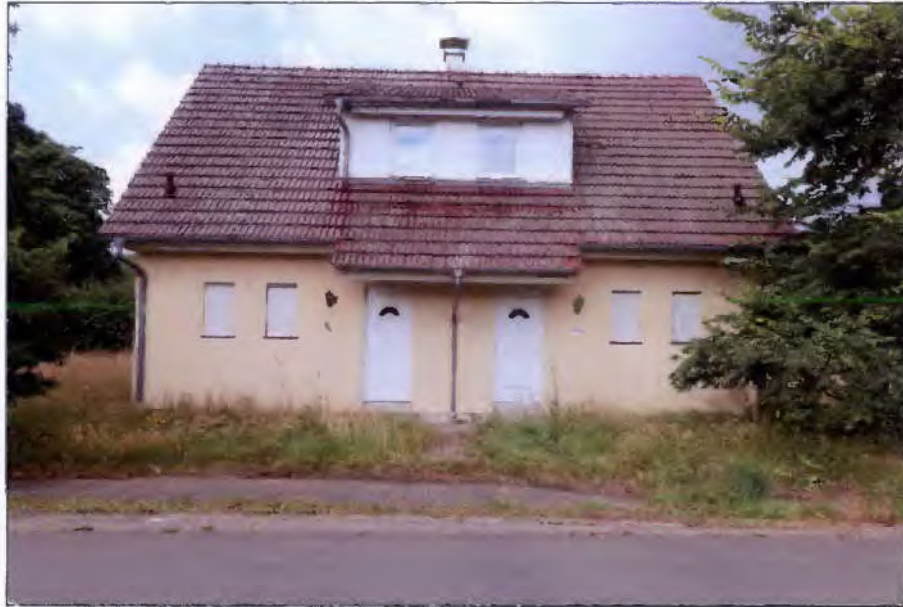
Blick auf das Ferienhaus aus östlicher Richtung
