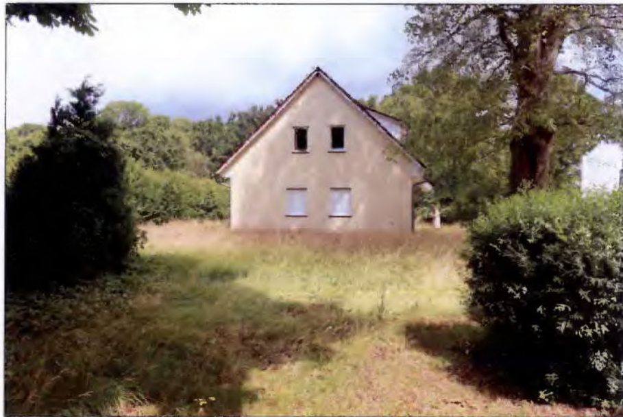
Blick auf das Gebäude aus südlicher Richtung
