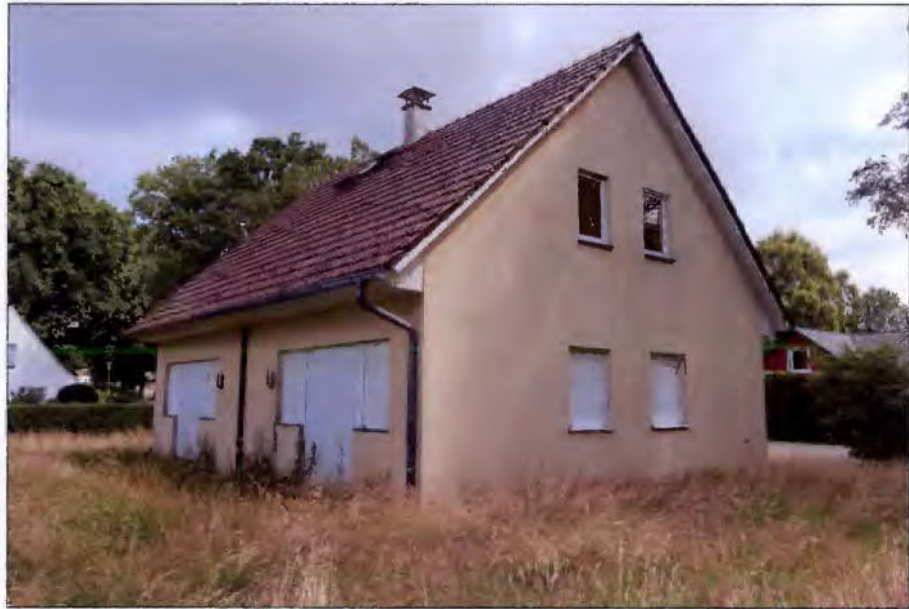
Blick auf das Gebäude aus südwestlicher Richtung
