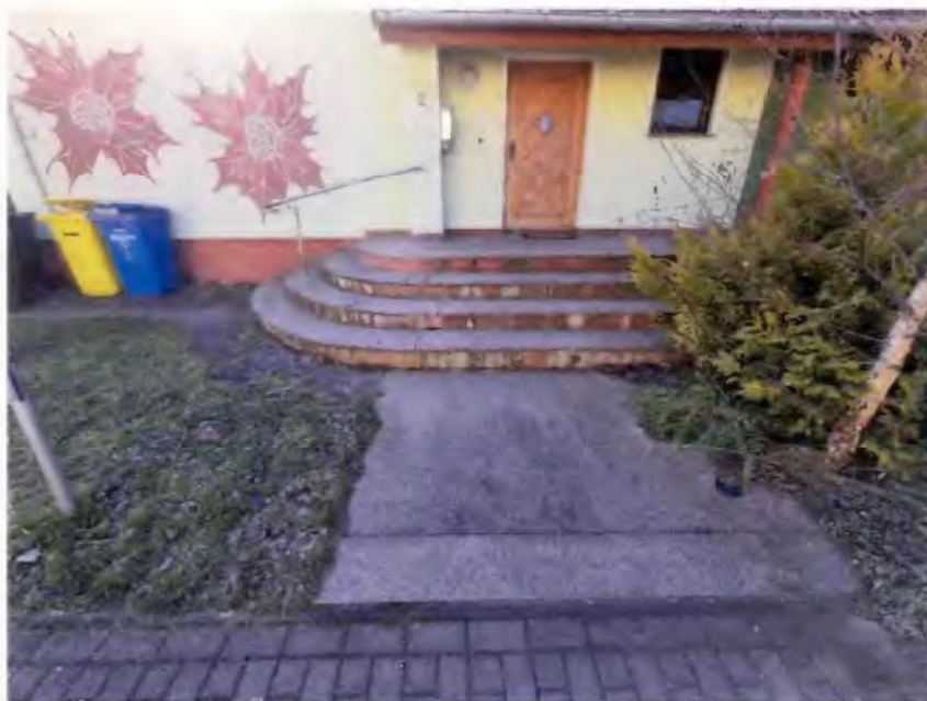
Foto 3: Zugang zum straßenseitigen Hauseingang
