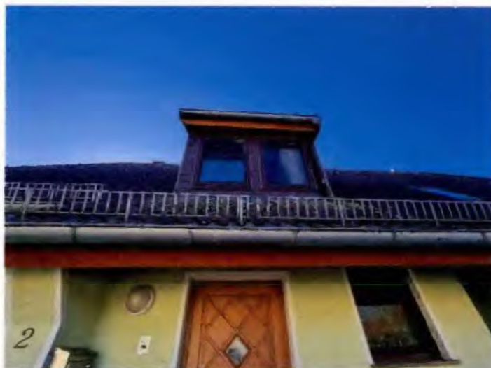
Foto 5: Teilansicht/Nordansicht Doppelhaushälfte (mit Gaube)
