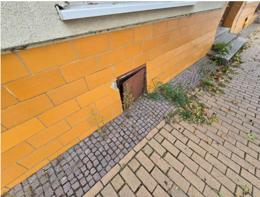
↑ Bild 8: Luken, vermutlich zu einer Teilunterkellerung
