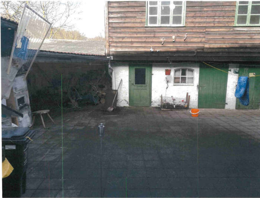
↑ Bild 13: Foto des Innenhofes vom 25.02.2021, übergeben vom zuständigen Bauamt
