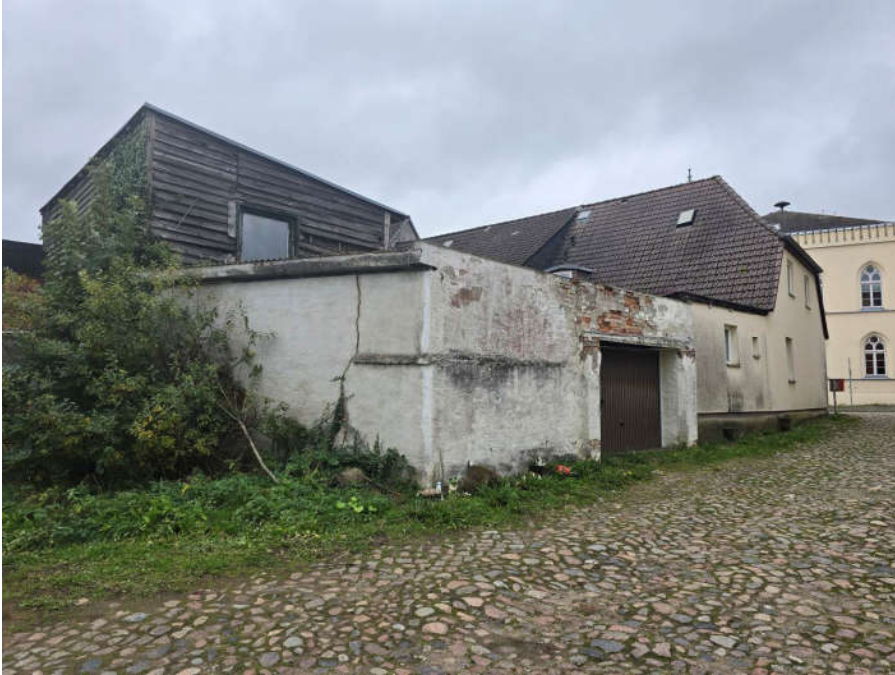
↑ Bild 3: westliche Grundstücksgrenze
