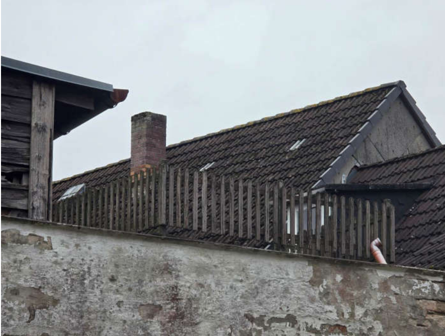
↑ Bild 5: Dachterrasse auf dem Nebengebäude
