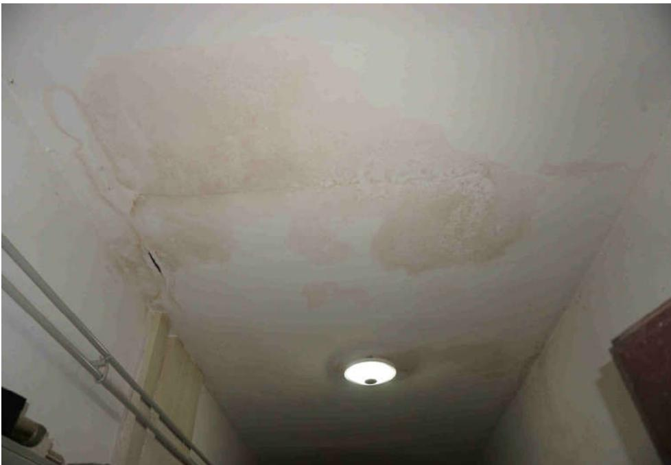
↑ **Bild 6:** Flurbereich mit Feuchteschäden an der Decke
