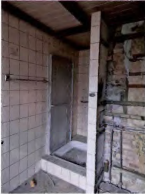
13 EG Innenansicht Bad 2 (Haupthaus)
