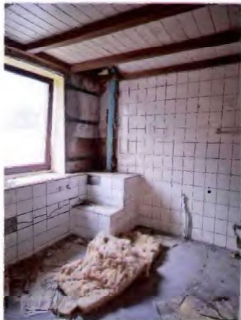
12 EG Innenansicht Bad (Haupthaus)
