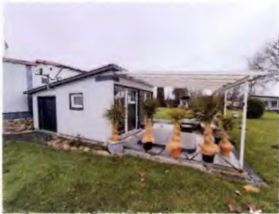
37 Nebengebäude Poolhaus mit überd. Terrasse
