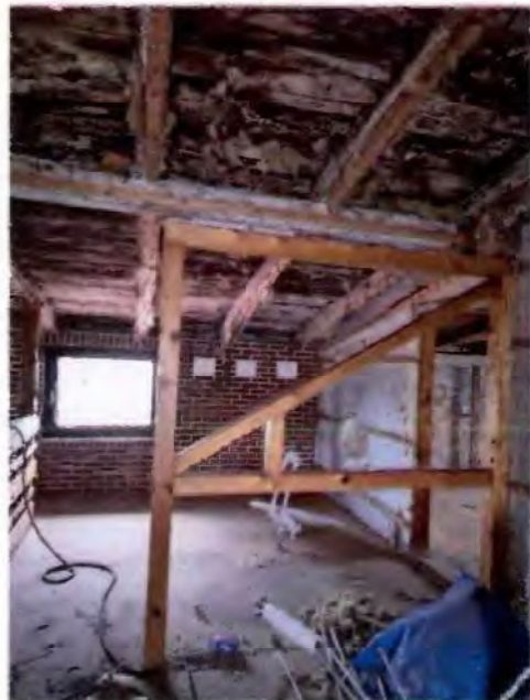
16 DG Innenansicht 1 (Haupthaus)
