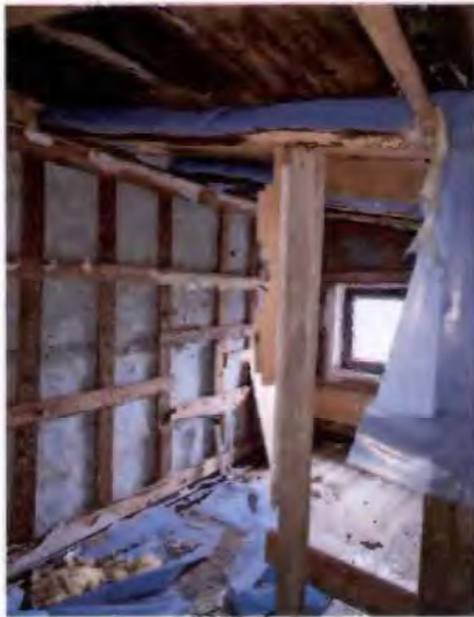
17 DG Innenansicht 2 (Haupthaus)
