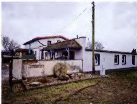
Blick aus Richtung Nordwesten (rechts im Bild: ehemalige Garage)
