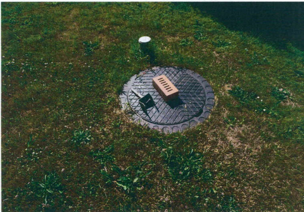
↑ Bild 6: Sammelgrube (abflusslose Grube)
