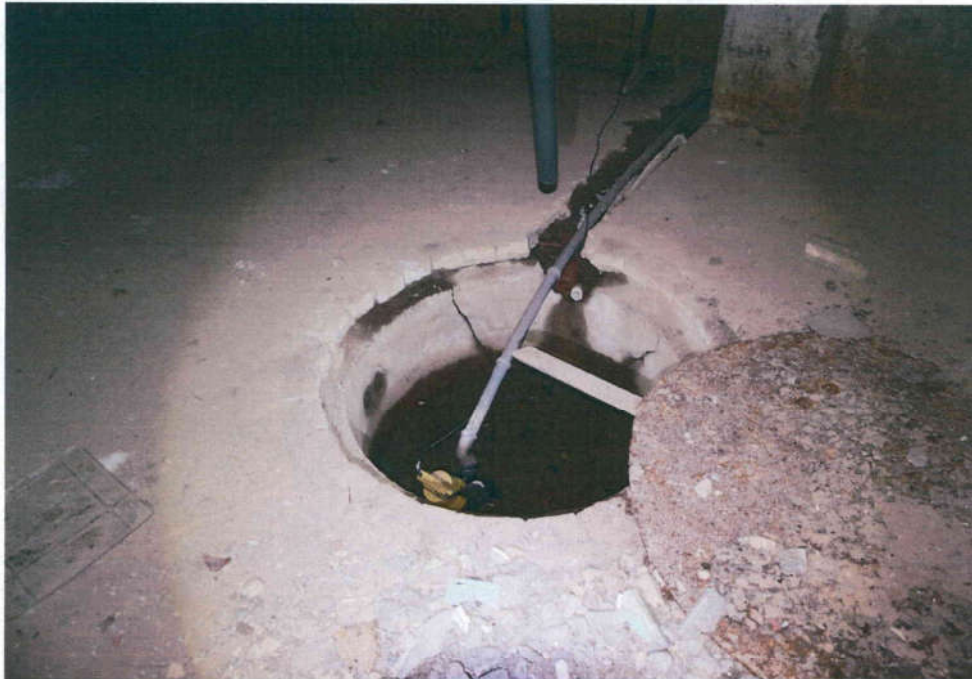
↑ Bild 21: Sammelschacht mit Pumpe im Kellergeschoss
