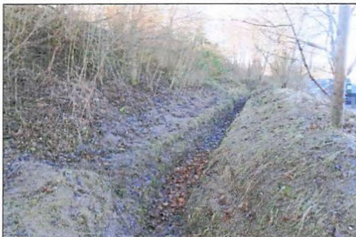
Flurstück 456 (westlicher Randbereich mit schmalen Graben)
