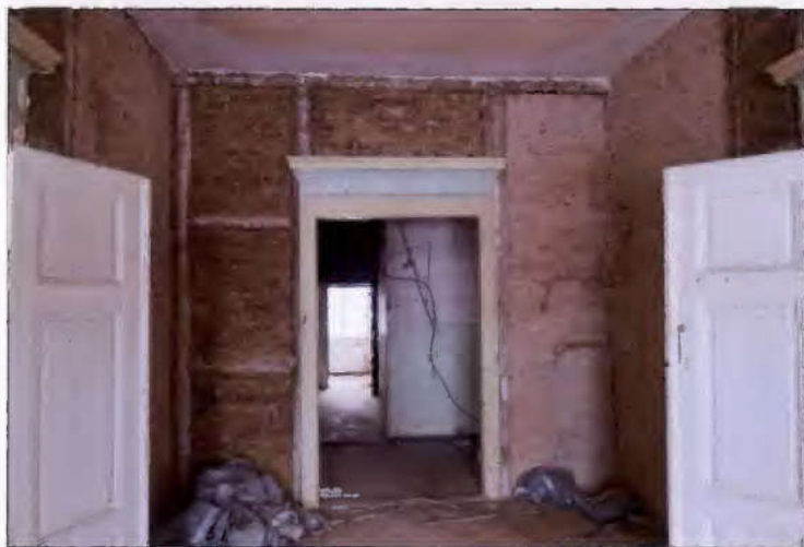
Erdgeschoss (bereits entkernter Bereich)
