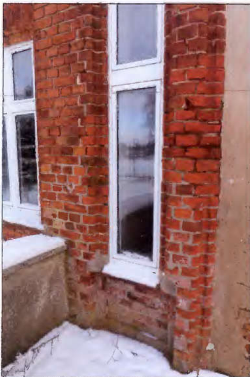
Detailansicht eines Kunststofffensters (nicht denkmalgerecht)
