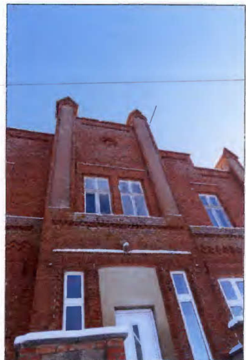
Detailansicht des Haupteingangs
