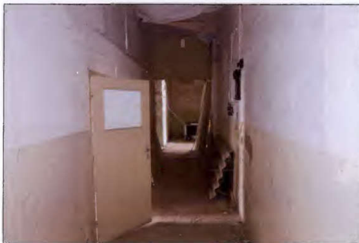
Flur im Erdgeschoss
