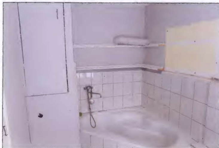
ehemaliges Bad der Wohnung im nördlichen Anbau
