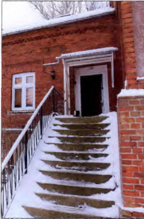
Hauseingang Nr. 9 (Anbau Nord)
