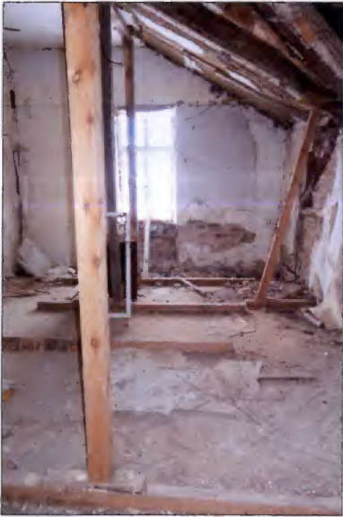
Raum im Dachgeschoss mit Abstützung des Daches
