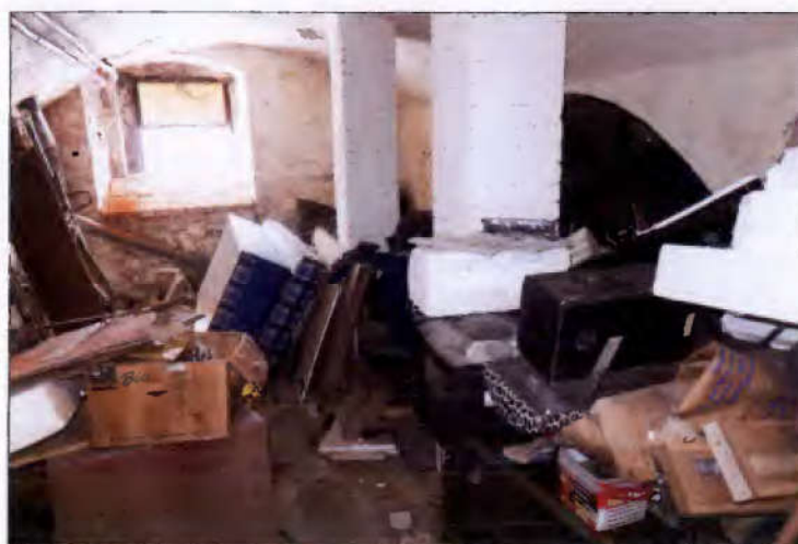
Blick in einen Kellerraum mit Beräumungsbedarf
