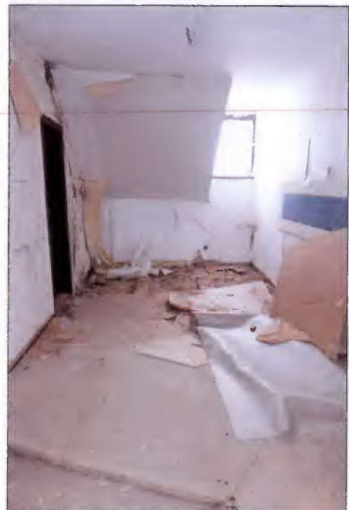
Raum im Dachgeschoss
