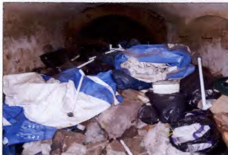
Blick in einen Kellerraum mit Beräumungsbedarf
