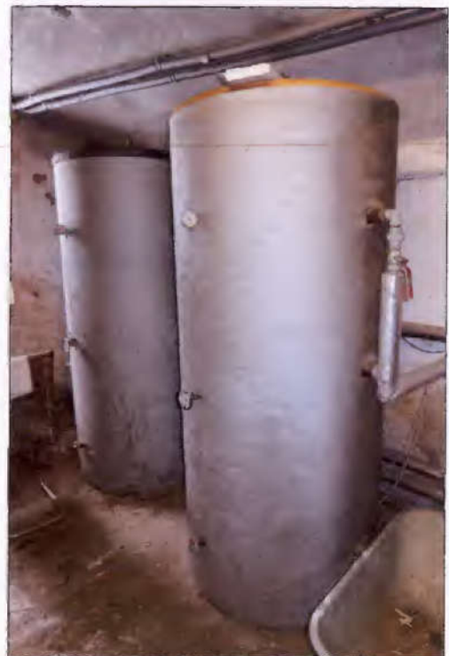
Pufferspeicher für den Feststoffbrenn- kessel
