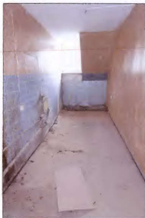
ehem. Küche einer Wohnung im Dachgeschoss
