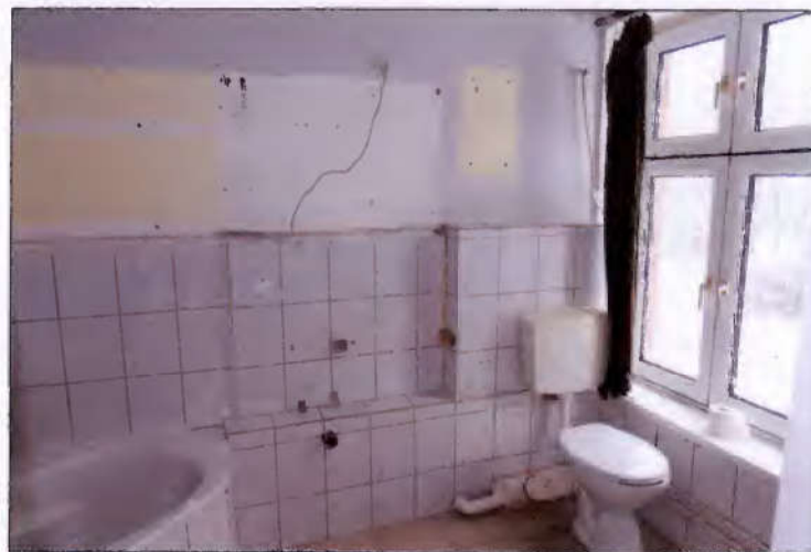
ehemaliges Bad der Wohnung im nördlichen Anbau
