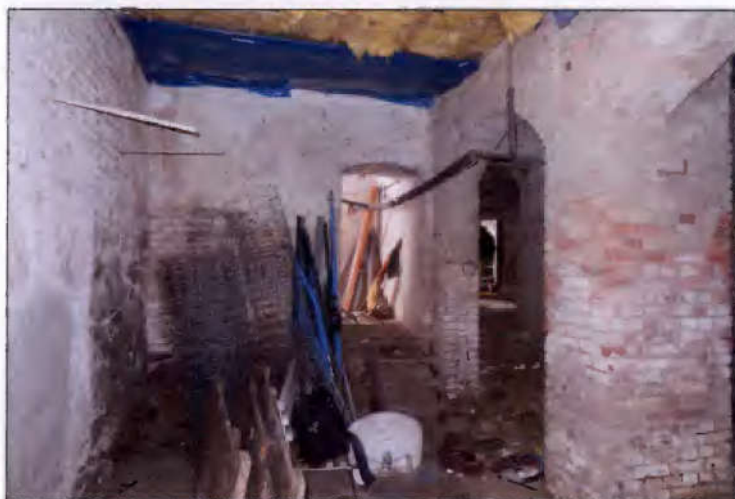
Kellerraum mit Außenzugang (Bereich nördlicher Anbau)
