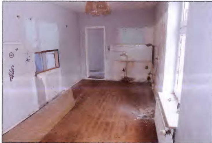
ehemalige Küche der Wohnung im nördlichen Anbau
