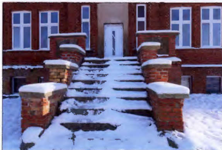
Blick auf den Haupteingang (Hauseingang Nr. 8)
