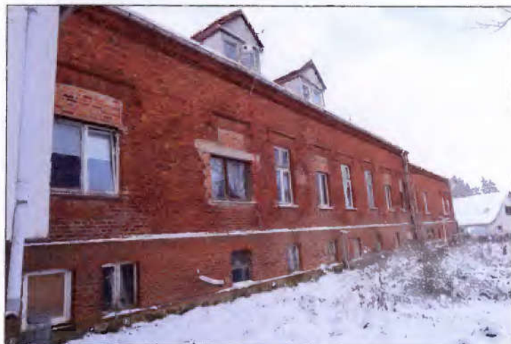
Ansicht der östlichen Fassadenseite des Gebäudes
