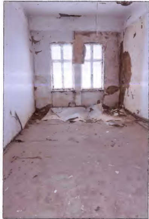
Raum im Dachgeschoss
