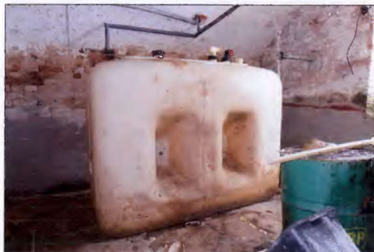
Kellerraum mit ehemaligem Heizöltank (Beräumungsbedarf)
