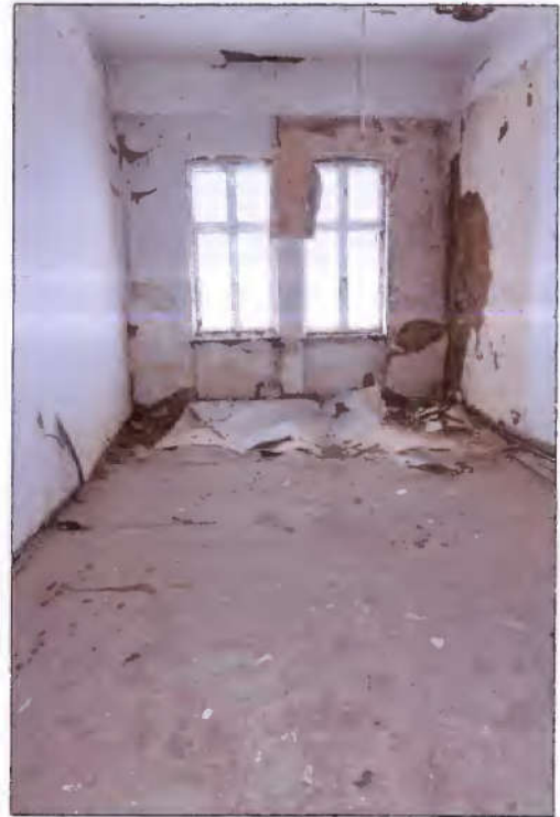
Raum im Dachgeschoss
