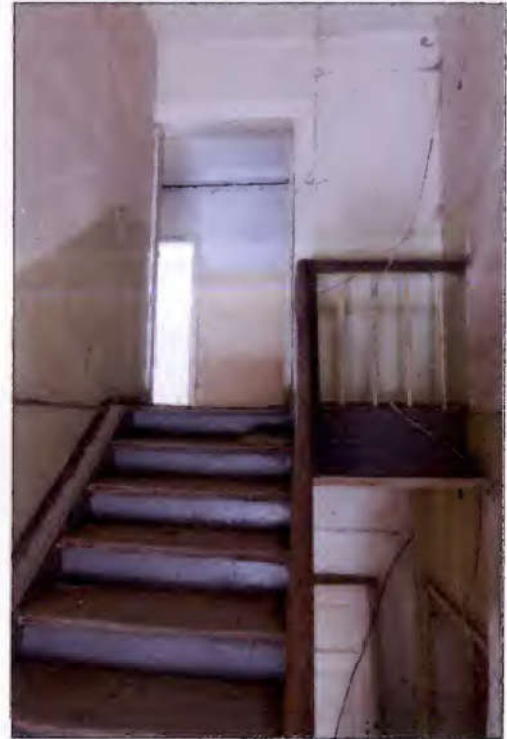
Treppe zum Dachgeschoss
