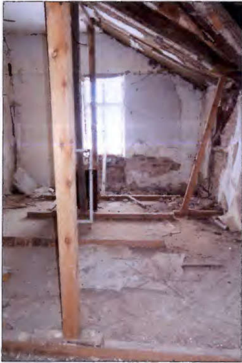
Raum im Dachgeschoss mit Abstützung des Daches
