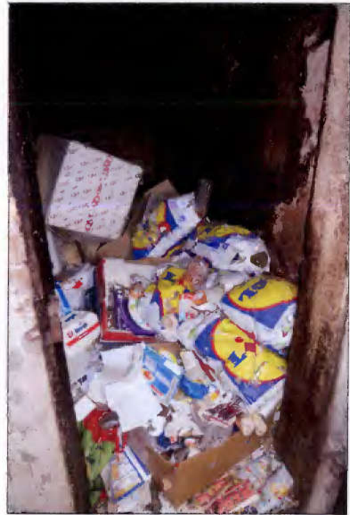
Beräumungsbedarf (ehem. Räucherkammer im Dach)
