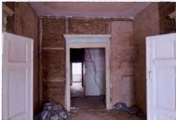
Erdgeschoss (bereits entkernter Bereich)
