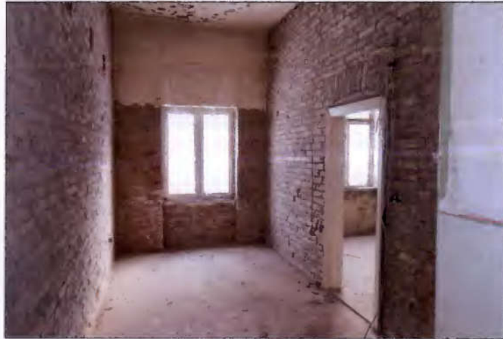
Erdgeschoss (bereits entkernter Bereich)
