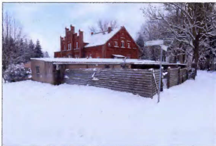
Ansicht des ehemaligen Gutshauses sowie der Garagenzeile aus südwestlicher Richtung
