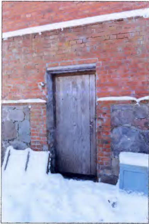
Außeneingang zum Kellergeschoss (Hauseingang Nr. 9 – Nord-Seite)
