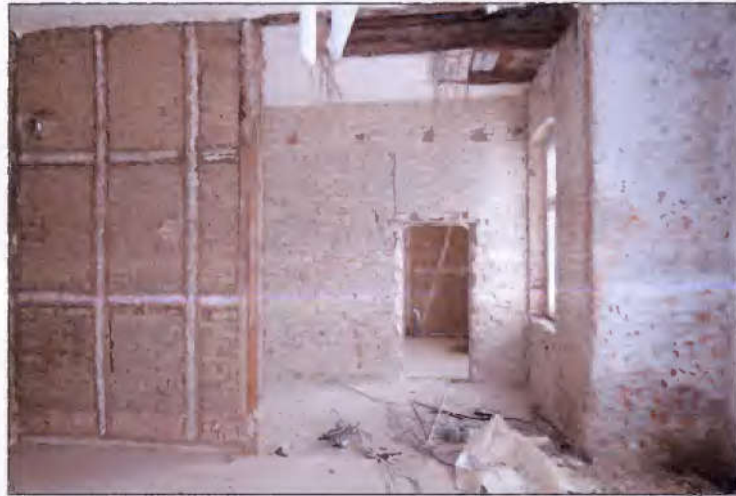
Erdgeschoss (bereits entkernter Bereich)
