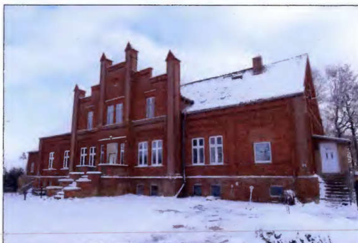
Blick auf das ehem. Gutshaus aus südwestlicher Richtung
