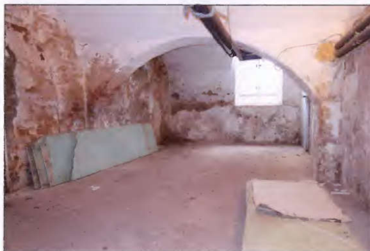
Blick in einen Kellerraum
