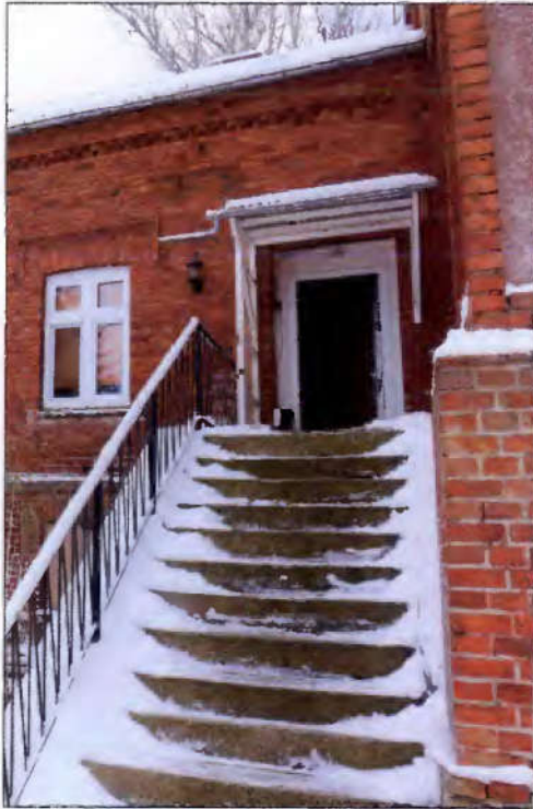
Hauseingang Nr. 9 (Anbau Nord)
