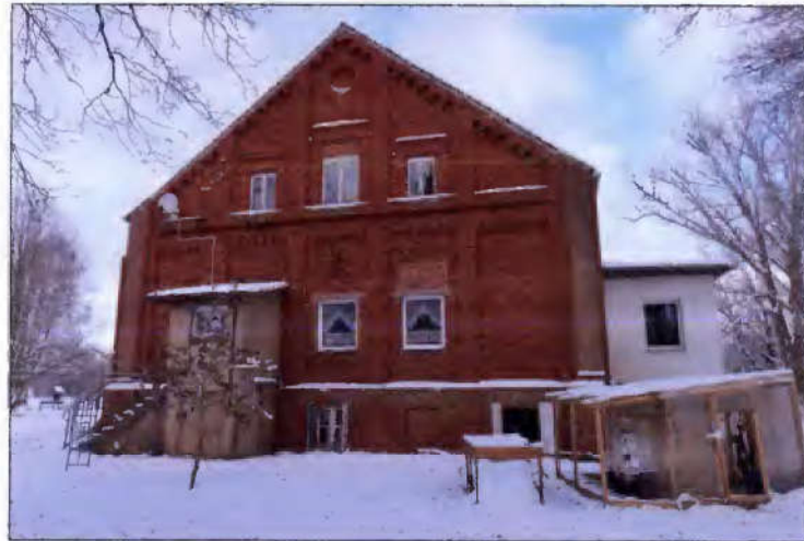
Blick auf den südlichen Giebel mit dem Eingangsbau (Haus Nr. 7)
