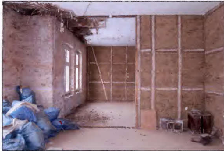
Erdgeschoss (bereits entkernter Bereich)
