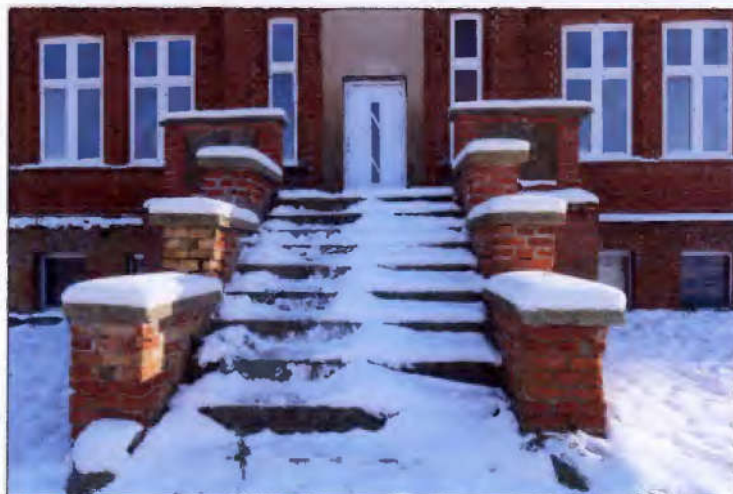
Blick auf den Haupteingang (Hauseingang Nr. 8)
