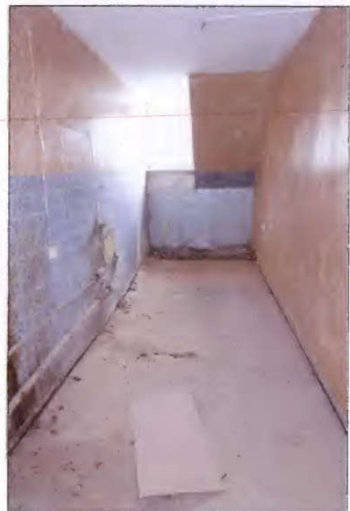
ehem. Küche einer Wohnung im Dachgeschoss
