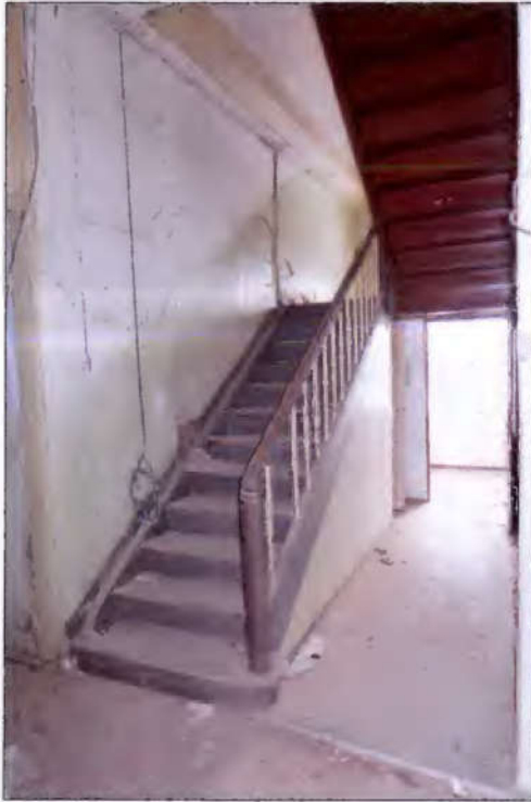
Treppe zum Dachgeschoss
