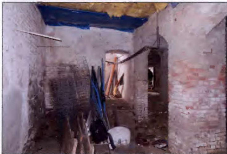
Kellerraum mit Außenzugang (Bereich nördlicher Anbau)
