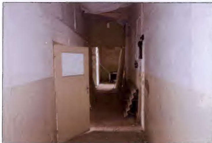
Flur im Erdgeschoss
