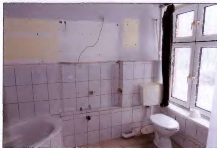
ehemaliges Bad der Wohnung im nördlichen Anbau
