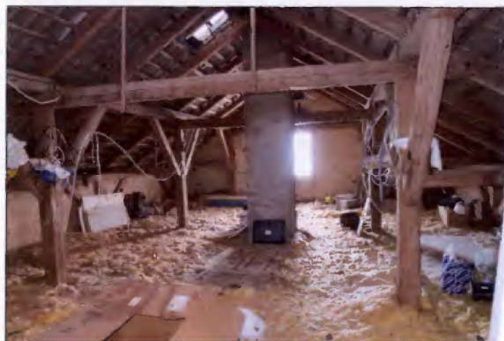
nicht ausgebautes Dachgeschoss des nördlichen Anbaus
