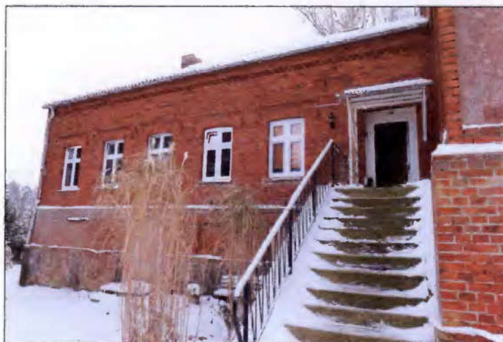
Blick auf den nördlichen Anbau (Hauseingang Nr. 9)
