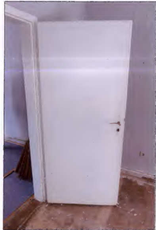
Innentür im Anbau
