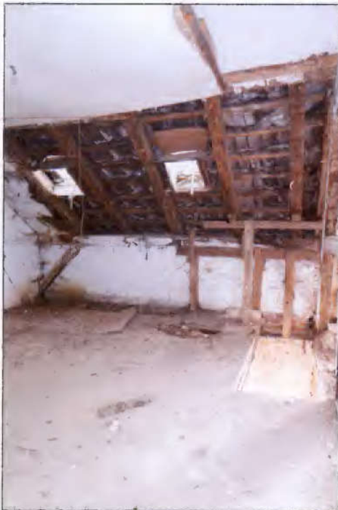
Raum im Dachgeschoss
