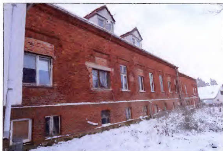
Ansicht der östlichen Fassadenseite des Gebäudes
