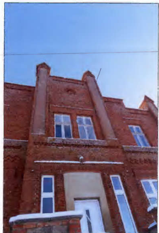
Detailansicht des Haupteingangs
