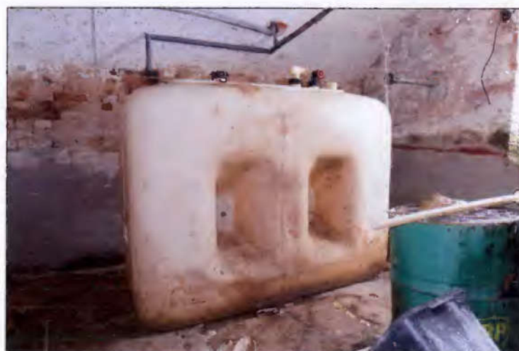
Kellerraum mit ehemaligem Heizöltank (Beräumungsbedarf)
