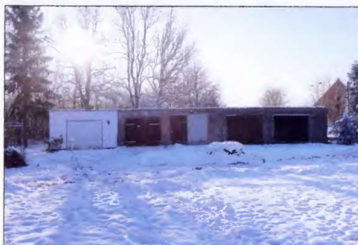
Blick auf die Garagenzeile an der südwestlichen Grundstücksgrenze
