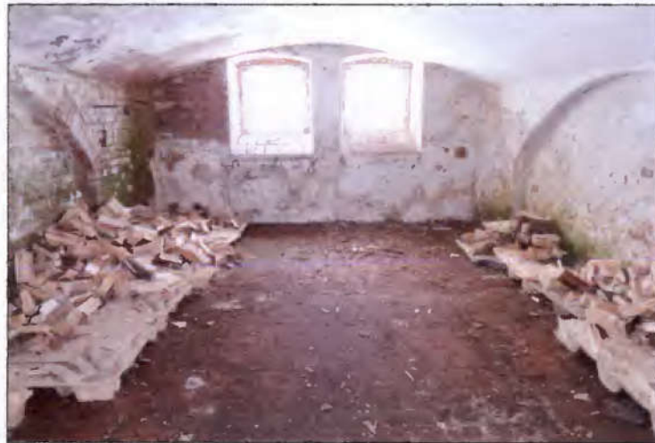
Blick in einen Kellerraum
