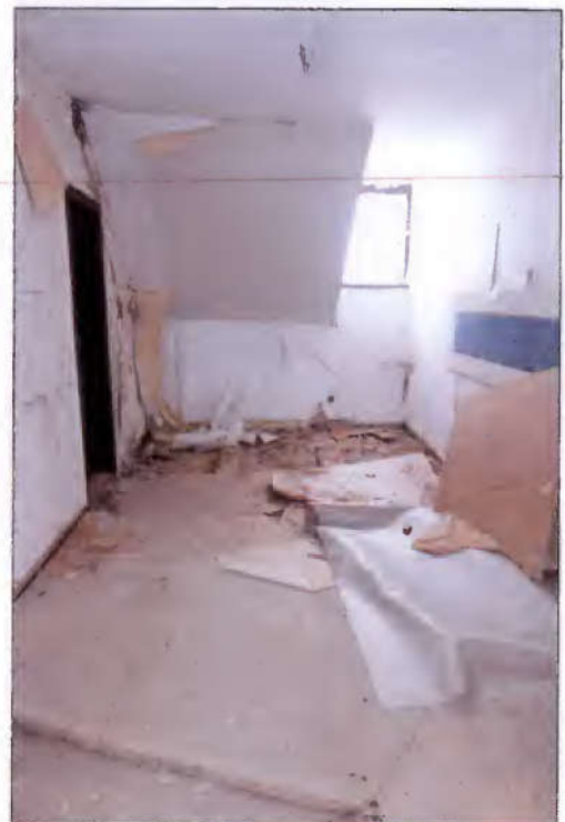
Raum im Dachgeschoss
