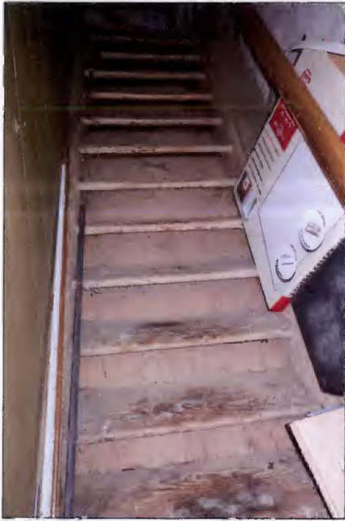
Treppe zum Dachgeschoss des nördlichen Anbaus
