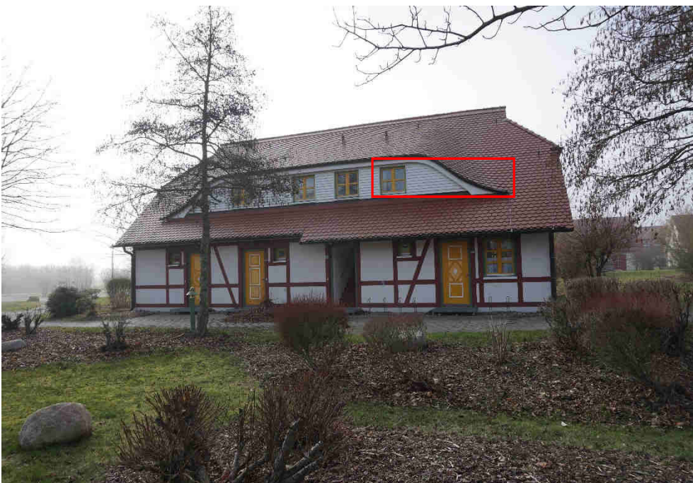
↑ Bild 4: Haus 23 mit offener Tür zu den Wohnungen 30 und 31
