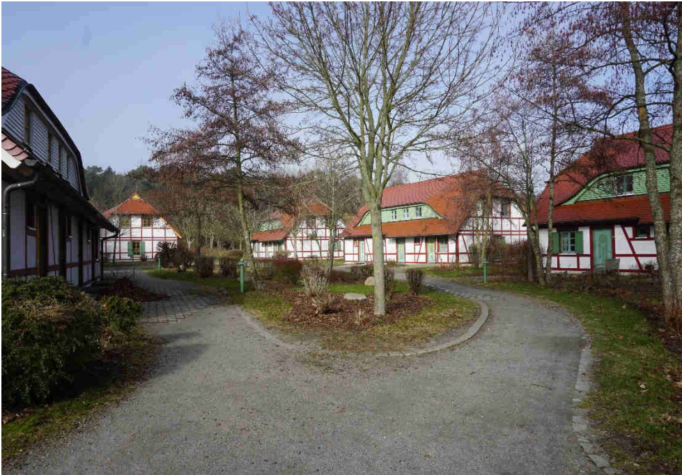
↑ Bild 3: Blick auf die Hausgruppe des Weiler B
