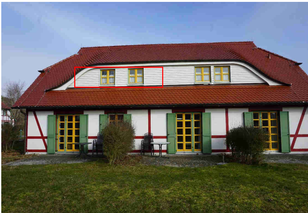
↑ Bild 6: Westseite des Haus 23
