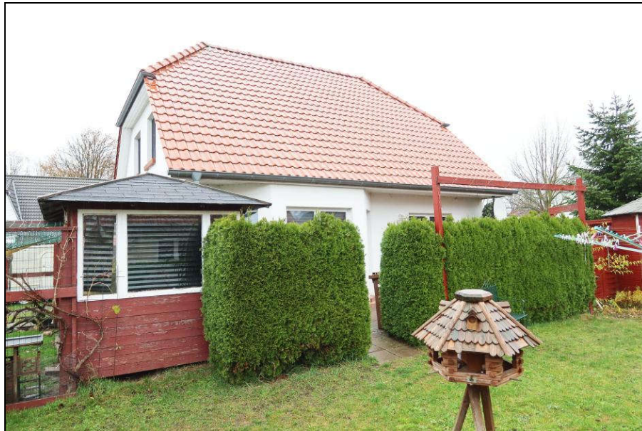
Ansicht des Einfamilienhauses aus südwestlicher Richtung
