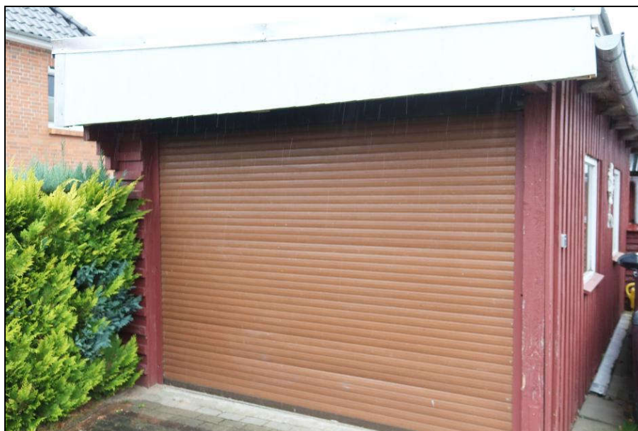
Blick auf den geschlossenen Carport an der westlichen Grenze des Grundstückes
