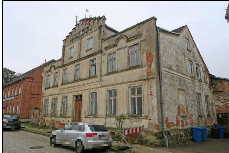
Ansicht des Mehrfamilienhauses aus nordöstlicher Richtung
