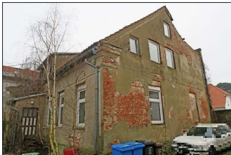
Blick auf das Gebäude aus südwestlicher Richtung
