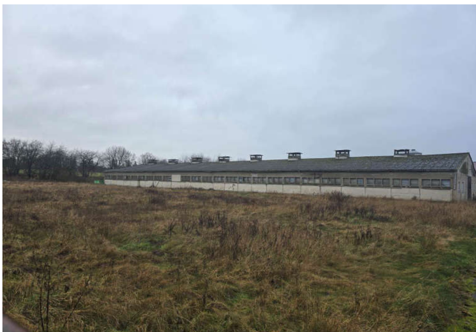
↑ Bild 6: Blick aus Richtung Süden auf die drei ehemaligen Putenmastställe
