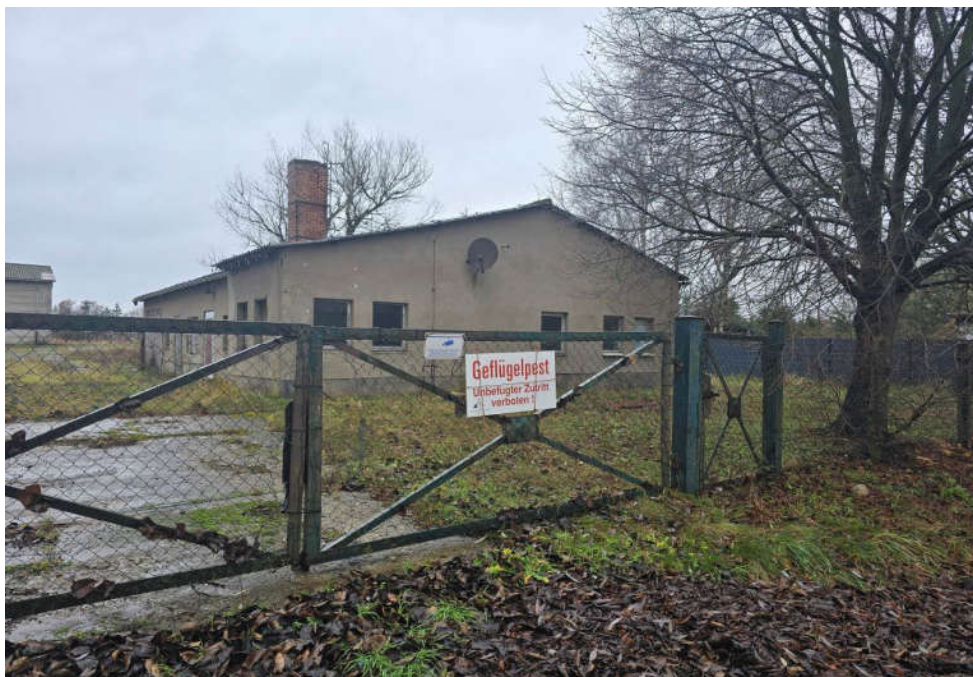
↑ Bild 1: Blick auf die südöstliche Grundstückszufahrt und das ehemalige Sozialgebäude
