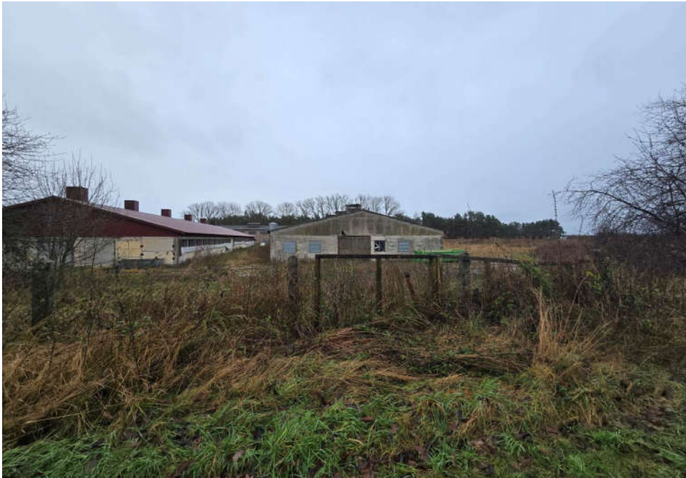
↑ Bild 13: Nordwestgiebel der ehemaligen Putenmastställe
