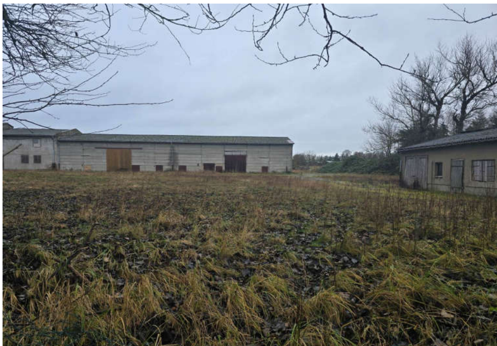
↑ Bild 2: Südostansicht des ehemaligen Strohlagers
