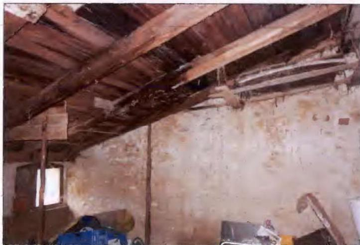
Blick auf den massiven Feuchtigkeitsschaden im Dachgeschoss
