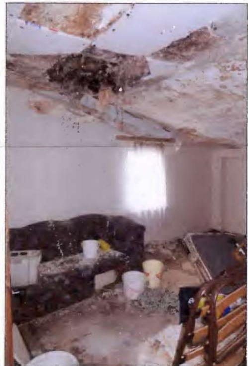
ausgebaute Kammer im Dachgeschoss mit massivem Feuchteschaden
