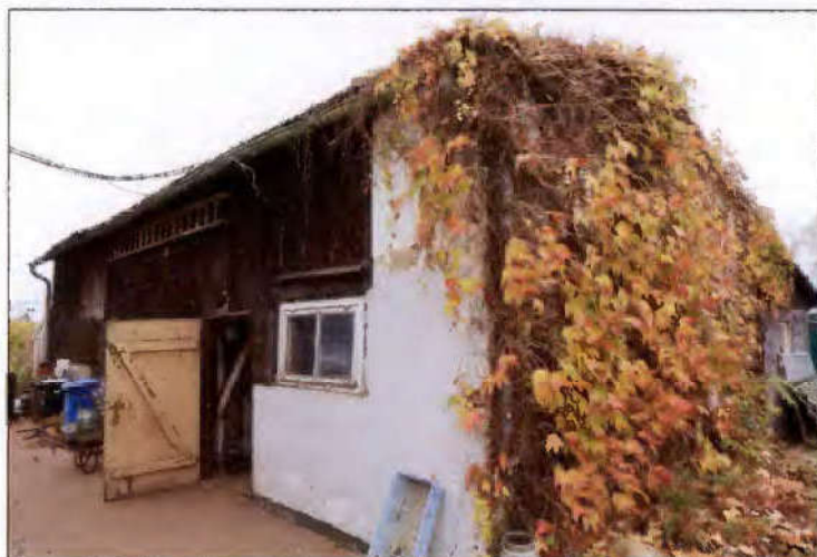
Blick auf das Stall-/ Scheunengebäude aus nordöstlicher Richtung
