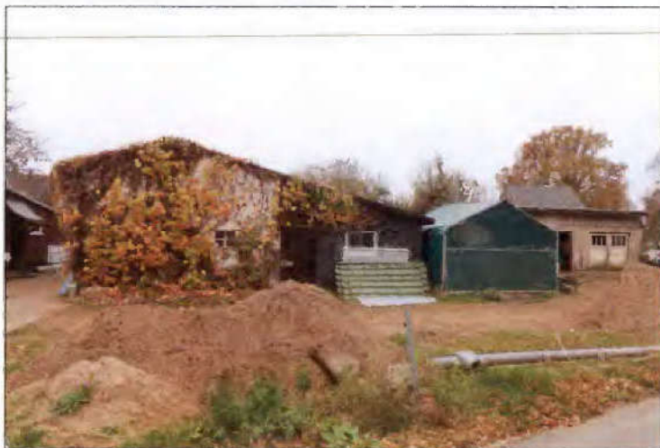
Blick auf das Stall-/ Scheunengebäude aus nördlicher Richtung
