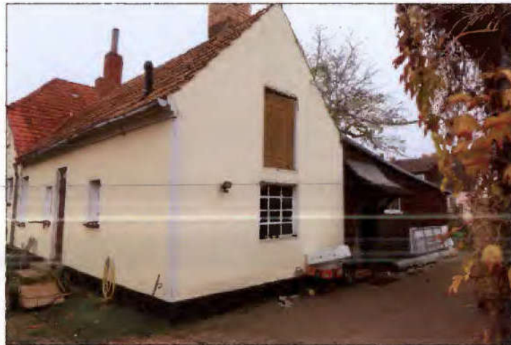
Blick auf den massiven Anbau sowie den Anbau in Holzbauweise
