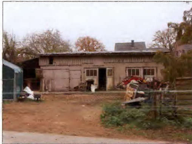
Blick auf die Doppelgarage / die Wagenscheune sowie den Verbindungsbau
