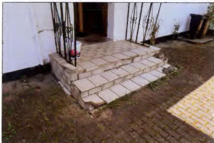
Detailansicht des Eingangspodestes mit massiven Abplatzungen der Fliesen
