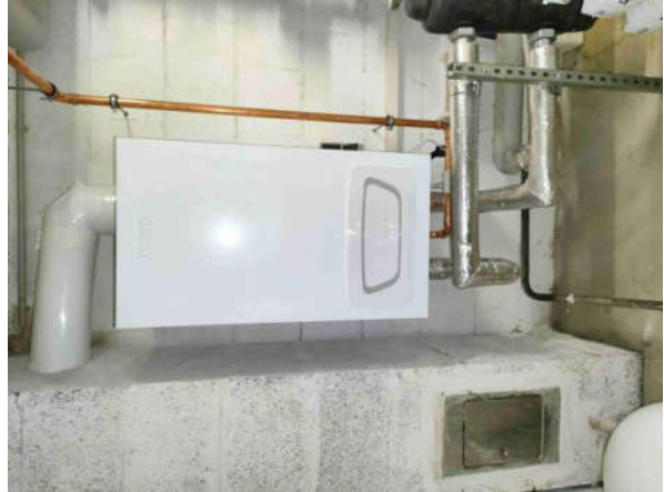
Bild 14-21 o Oben: Ansichten vom Kellergeschoss: Treppe, Kellergang, Waschmaschinenraum, Zählerschrankraum o Unten: Ansichten vom Kellergeschoss: Heizungsanlage (erneuerte Gastherme und Warmwasserspeicher), Enthärtungsanlage
