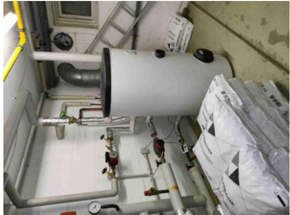
Bild 14-21 o Oben: Ansichten vom Kellergeschoss: Treppe, Kellergang, Waschmaschinenraum, Zählerschrankraum o Unten: Ansichten vom Kellergeschoss: Heizungsanlage (erneuerte Gastherme und Warmwasserspeicher), Enthärtungsanlage
