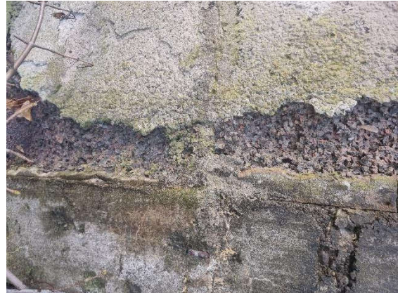
Bild 14: angegriffener Betonsockel Stall 1
