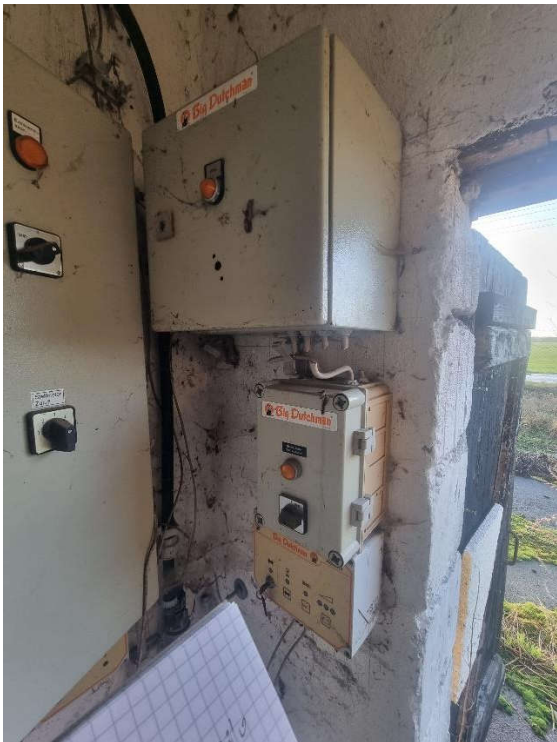
Bild 18: ehemalige Schalt- und Steuerungsanlagen
