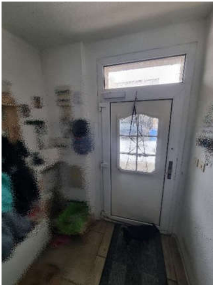
Bild 14: Haustür Wohnung 1 und E-Verteilung
