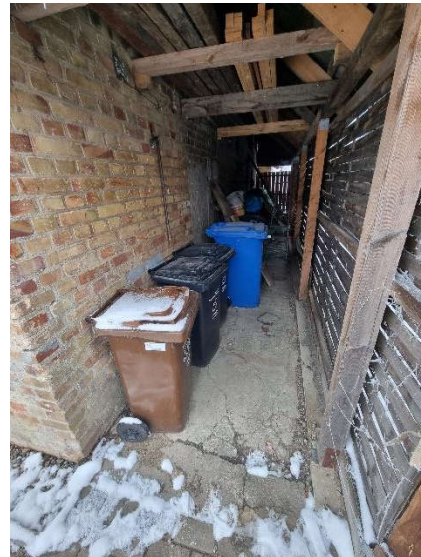
Bild 22: nördliche Überdachung am Nebengebäude
