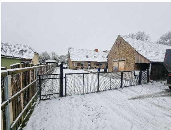
Bild 3: Zugang / Zufahrt zum Bewertungsobjekt
