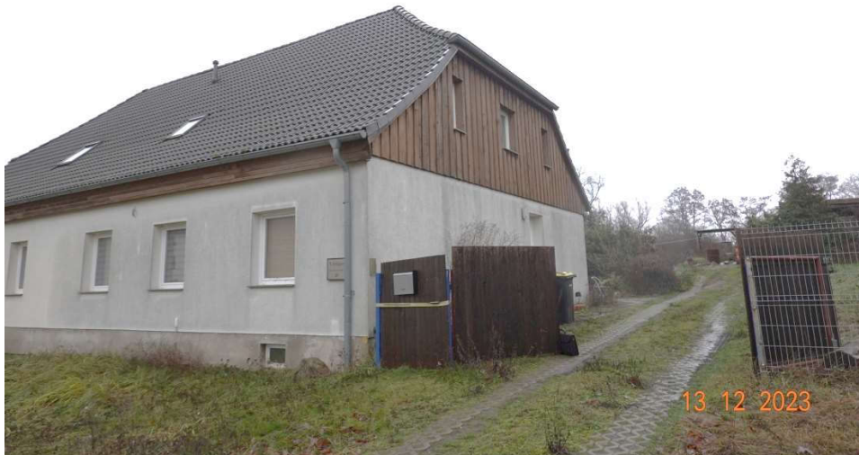
Bild 1: Darstellung des Bewertungsobjekts aus südwestlicher Richtung
