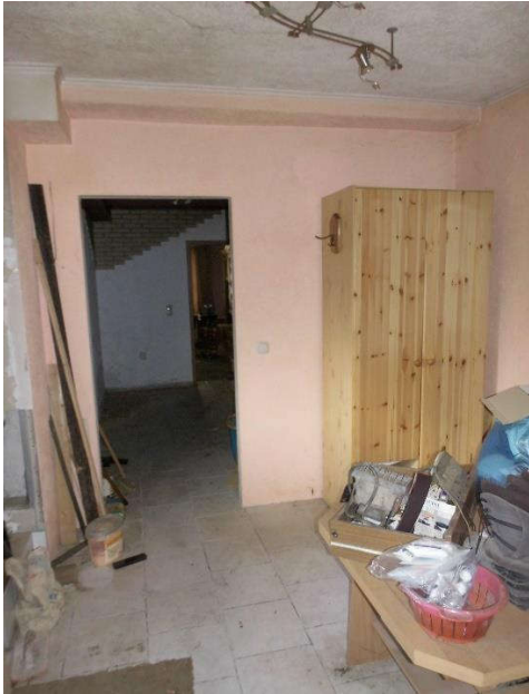
Bild 17: Innenansicht des Einfamilienhauses, EG Zimmer Anbau
