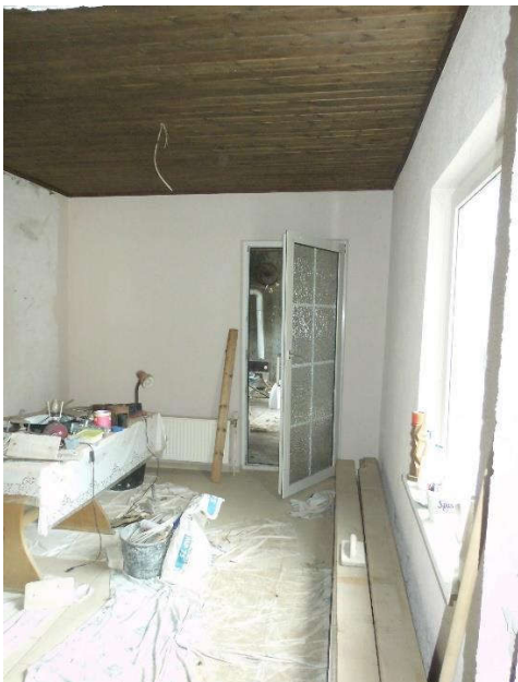
Bild 31: Innenansicht des Einfamilienhauses, OG Zimmer Anbau
