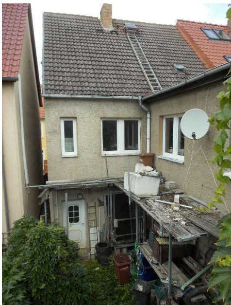
Bild 7: Ansicht des Einfamilienhauses vom rückwärtigen Grundstücksteil aus
