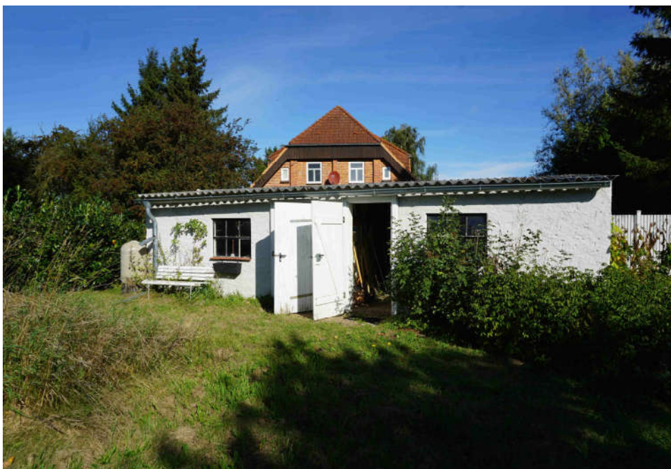
↑ Bild 19: zur Garage mit Werkstatt umgebauter ehemaliger Stall
