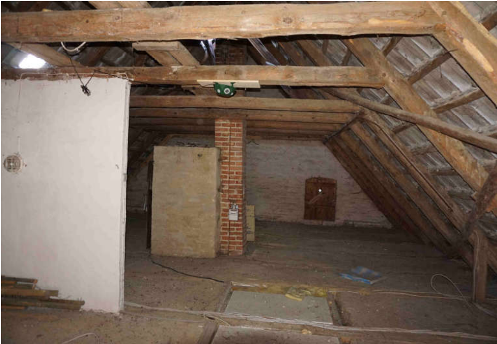
↑ Bild 15: nicht ausgebautes Dachgeschoss
