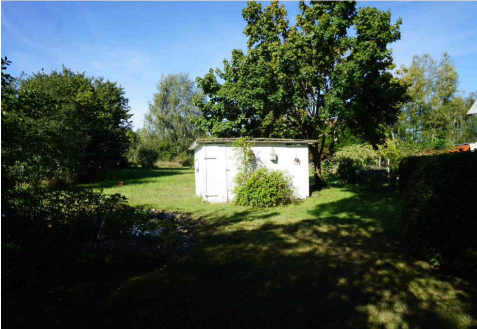
↑ Bild 16: baufälliger Schuppen
