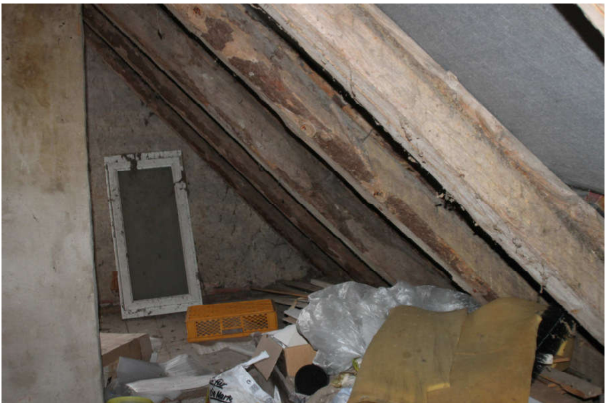
Bild 44: Blick in eine Abseite im Dachgeschoss
