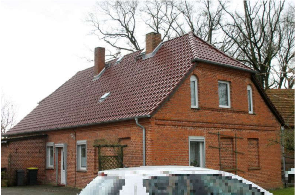
Bild 5 und Bild 6: Rückfront des Wohnhauses
