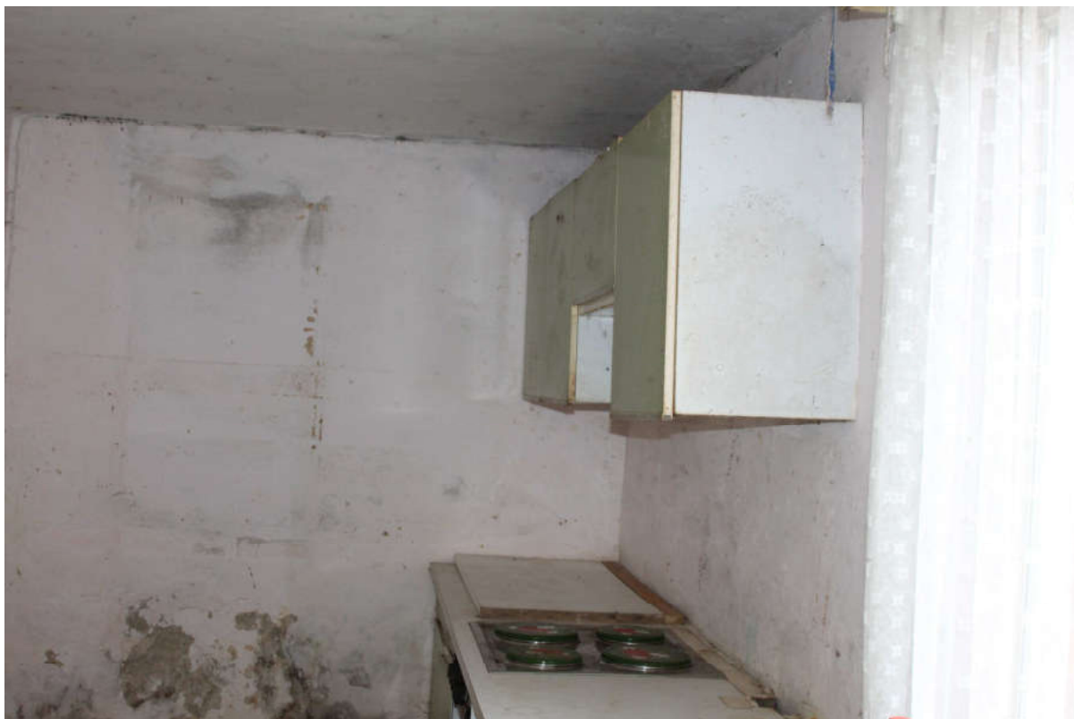
Bild 35 und Bild 36: Blick in den hofseitigen Anbau, Zugang zum ehemaligen Klassenraum
