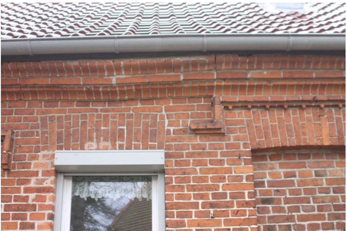
Bild 16: Detail des Traufgesims zur Straßenseite
