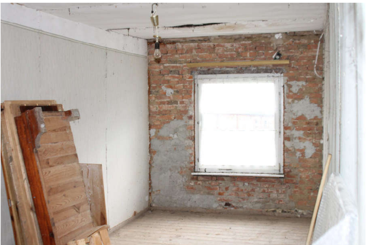
Bild 42: Sicht in ein Giebelzimmer im Dachgeschoss
