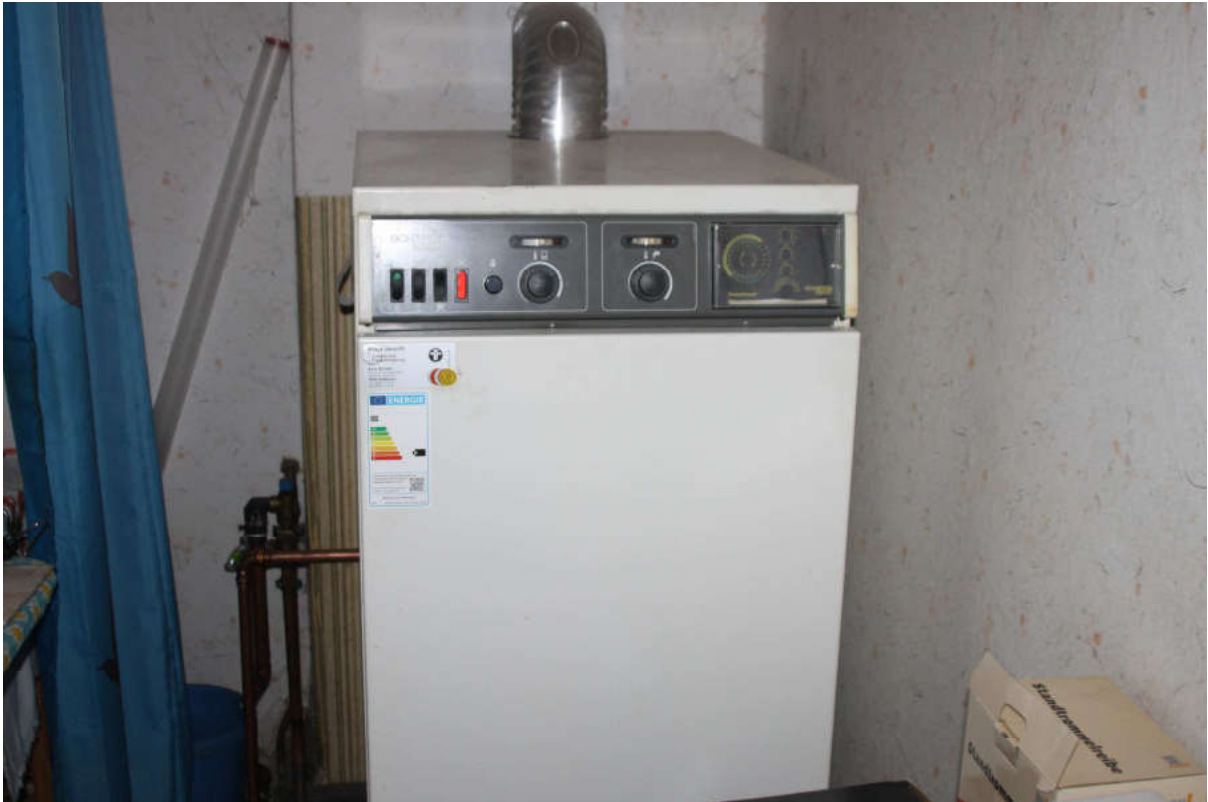
Bild 29 und Bild 30: Blick auf den Niedertemperaturkessel im Wohnhaus
