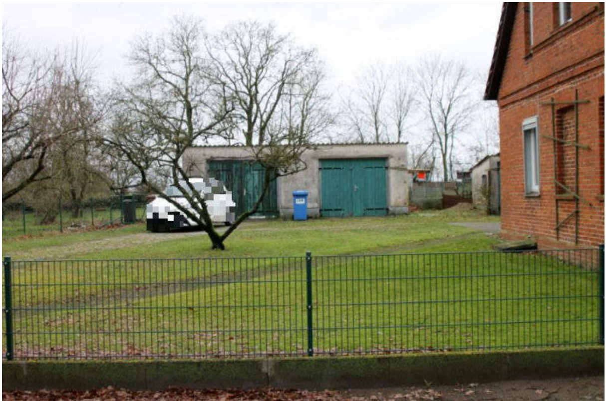
Bild 11: Blick von der Mölliner Straße auf die Doppelgarage
