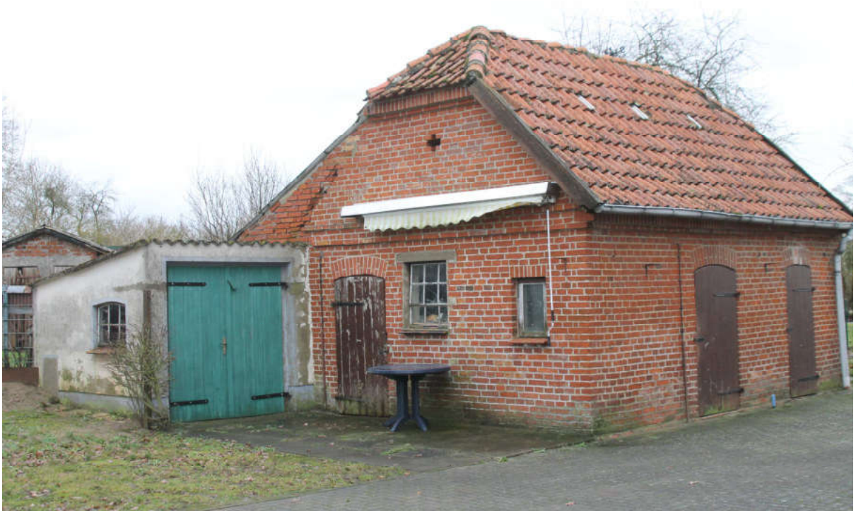
Bild 8: Sicht auf das ehemalige Stallgebäude mit angebauter Garage
