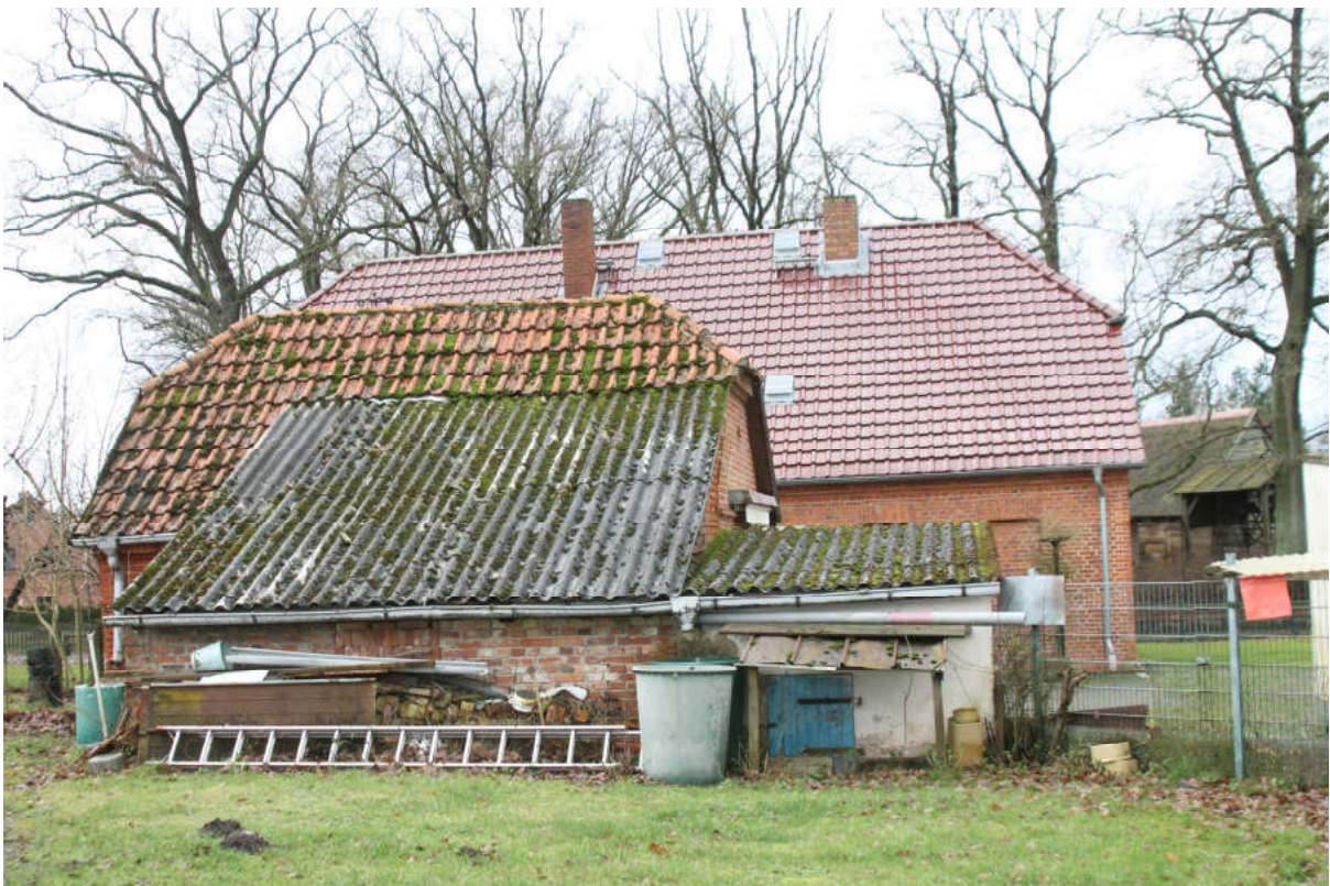
Bild 10: Rückfront des Stallgebäudes mit angebauter Garage
