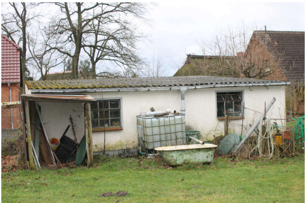
Bild 12: Rückfront der Doppelgarage
