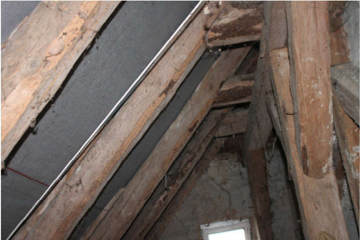
Bild 49: Abseite im Dachgeschoss
