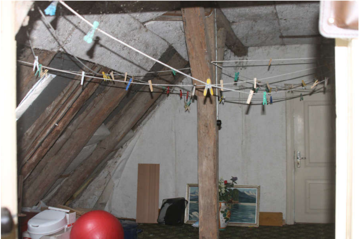
Bild 43: Trockenboden im Dachgeschoss
