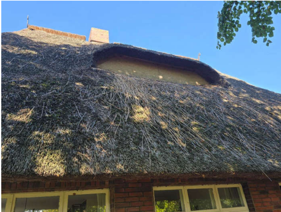
↑ Bild 5: vorbereitete Dachgaube im Spitzbodenbereich (blind)
