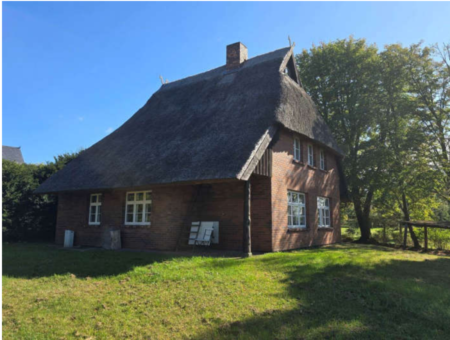
↑ Bild 3: Blick aus Richtung Nordwesten aus das Einfamilienwohnhaus
