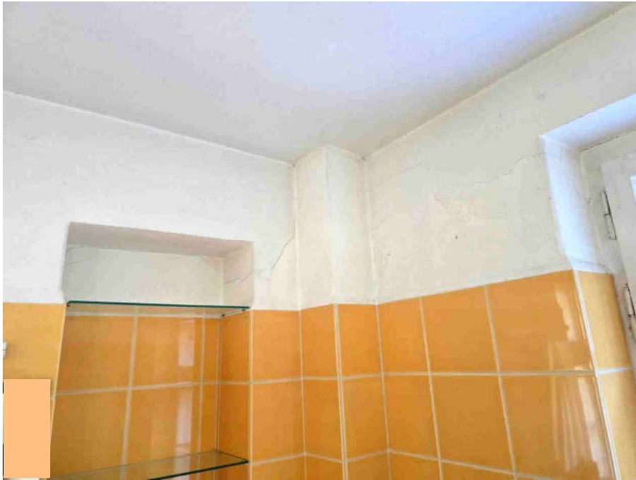
↑ Bild 15: Setzungsrisse
