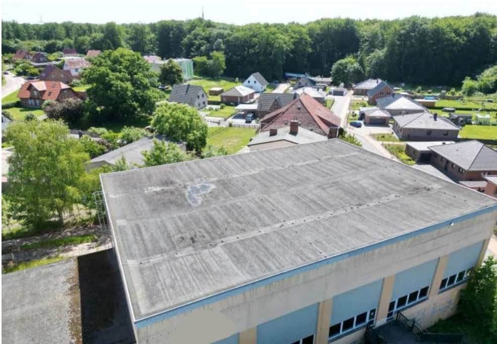
↑ Bild 37: Drohnenaufnahme des Saalgebäudes
