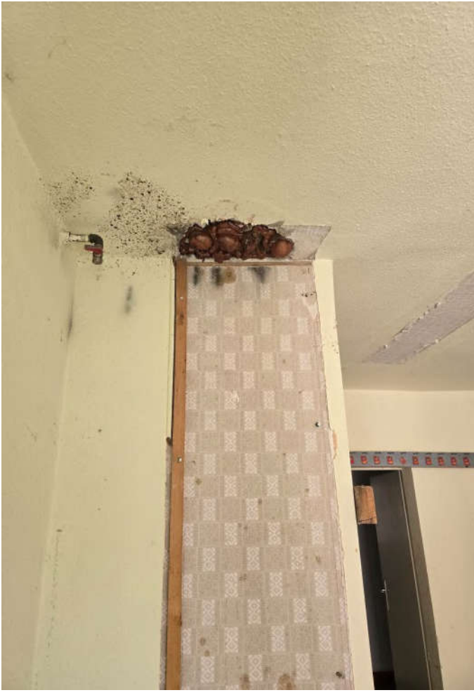
↑ Bild 16: zurückgebaute Leitungen
