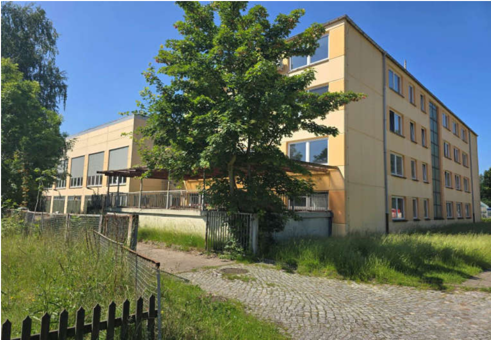
↑ Bild 5: Ostgiebel des Bürogebäudes
