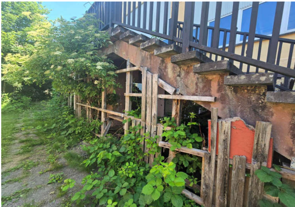
↑ Bild 4: Verschlag unter der Außentreppe des Saalgebäudes
