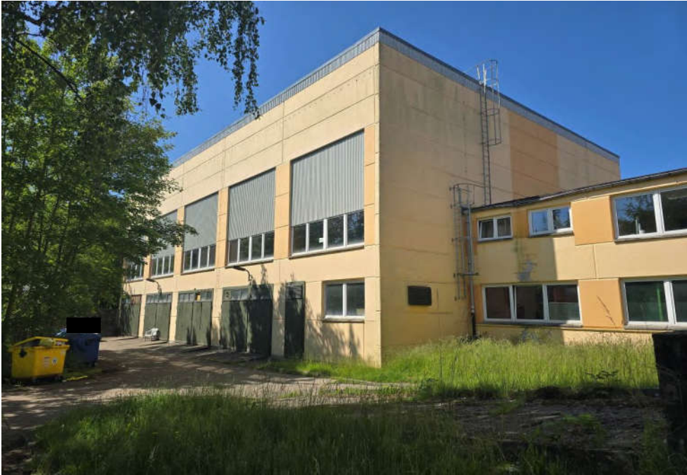
↑ Bild 6: Ostansicht von Zwischenbau und Saalgebäude
