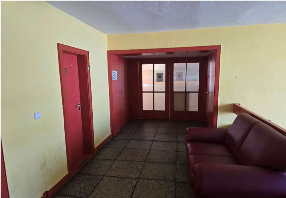
↑ Bild 29: Flur im Zwischenbau mit Tür zum Saal (verschlossen)
