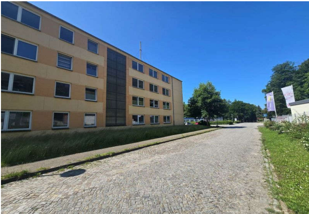
↑ Bild 1: Blick auf die Nordseite des Bürogebäudes
